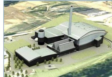
Estas plantas permiten aprovechar energéticamente los residuos: con el calor producido por la combustión de los residuos, se genera vapor, que, al pasar por una turbina, produce electricidad. También se puede recuperar directamente el calor e incorporarlo en una red de calor (si existe).
