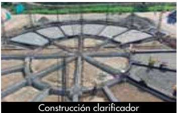
Construcción clarificador
