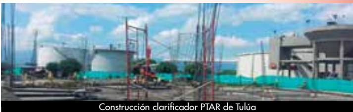
Construcción clarificador PTAR de Tuluá
