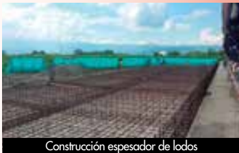
Construcción espesador de lodos
