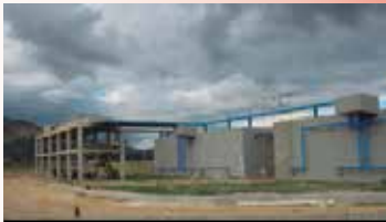
Espesadores – digestores y estructura filtro prensa
