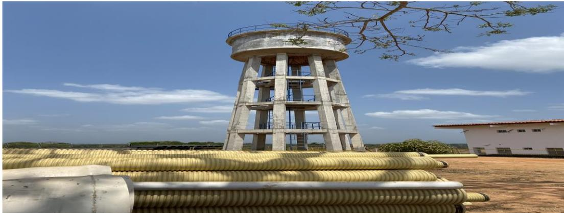
*Imagen 5 Tanque de Almacenamiento de la PTAP con capacidad de 350 l/s, el cual no está conectado hidráulico del proyecto perteneciente al proyecto denominado: “Construcción del Sistema de Acueducto Regional San Jorge municipios de La Apartada, Buenavista, Planeta Rica, Pueblo Nuevo”, ubicado en el departamento de Córdoba.*
