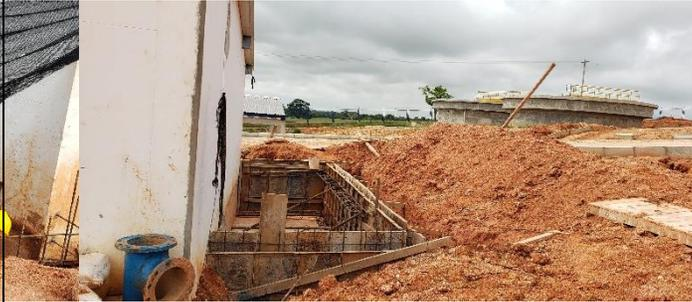
**FOTO No.2:** armado de formaletas para fundir muros.
