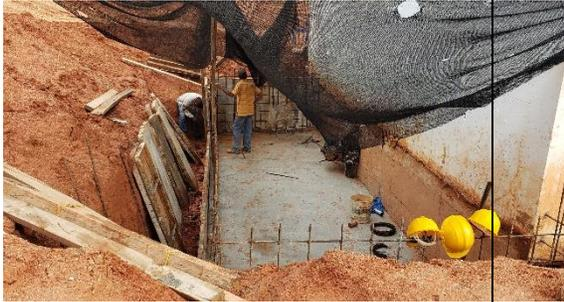
**FOTO No.1:** fondo de caja fundido y armado de formaletas para muros
