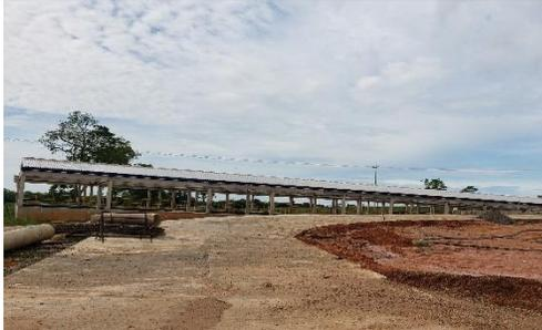
**FOTO No.5:** anillo vial planta, vista de lechos de secado de lodos
