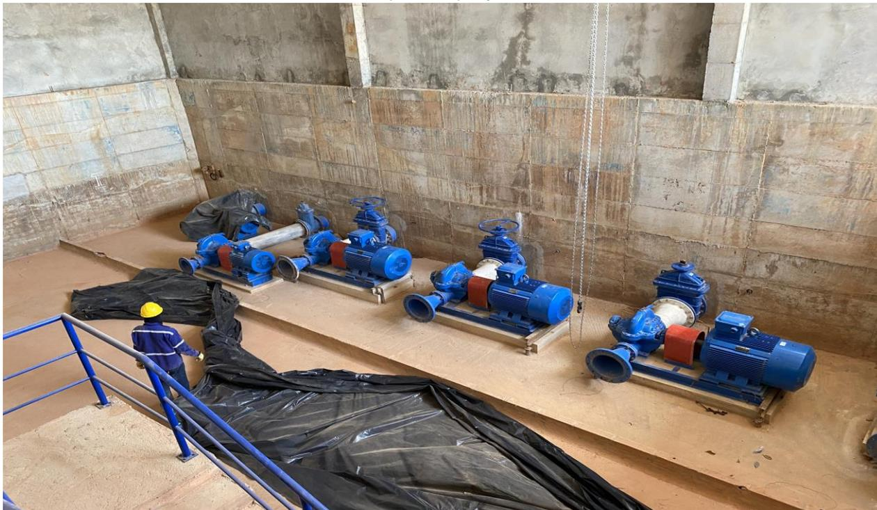
*Imagen 3. Sistema de Bombeo de la PTAP con capacidad de 350 l/s, el cual no está conectado al sistema eléctrico ni hidráulico del proyecto perteneciente al proyecto denominado: “Construcción del Sistema de Acueducto Regional San Jorge municipios de La Apartada, Buenavista, Planeta Rica, Pueblo Nuevo”, ubicado en el departamento de Córdoba*
