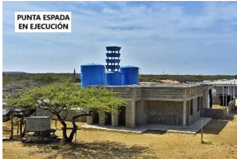
PUNTA ESPADA EN EJECUCIÓN Construcción de obras en el punto de producción, sistema de ósmosis inversa, construcción pilas aferente, suministro de dotación para pilas componente social y aseguramiento en la comunidad de Punta Espada, Uribia
