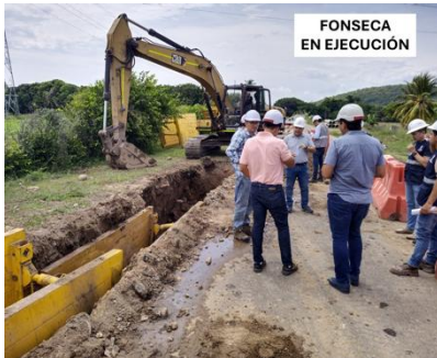
FONSECA EN EJECUCIÓN Optimización del acueducto de Fonseca
