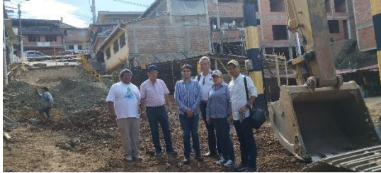
Optimización del tramo de alcantarillado colapsado en la carrera 6, entre la vía principal y la calle 9 por ola invernal en el barrio corea del corregimiento de Borrero Ayerbe Dagua, Valle del Cauca
