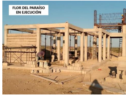
FLOR DEL PARAÍSO EN EJECUCIÓN Construcción de un sistema de abastecimiento de agua, mediante el esquema de pilas públicas en Flor del Paraíso zona rural, Uribia
