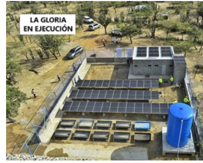
LA GLORIA EN EJECUCIÓN Construcción de obras en el punto de producción, sistema de ósmosis inversa, construcción pilas aferentes, suministro de dotación para pilas, componente social y aseguramiento en la comunidad de La Gloria, Manaure
