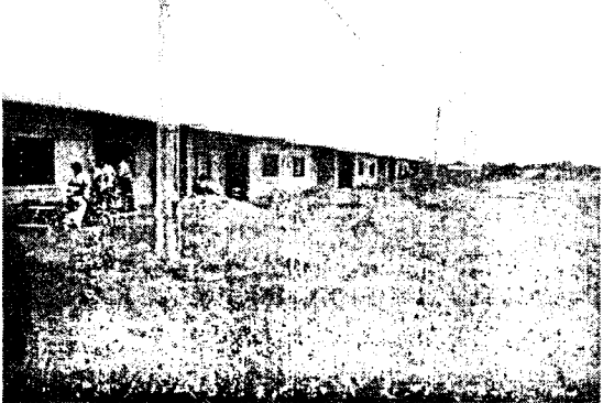
Viviendas Construidas y en proceso de entrega a las familias
