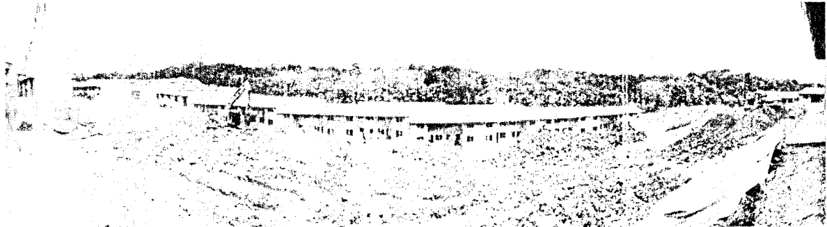
Foto No 8. Panorámica de la construcción de la segunda etapa del Macroproyecto San Antonio
