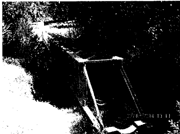
Estructura metálica, para Paso Elevado
