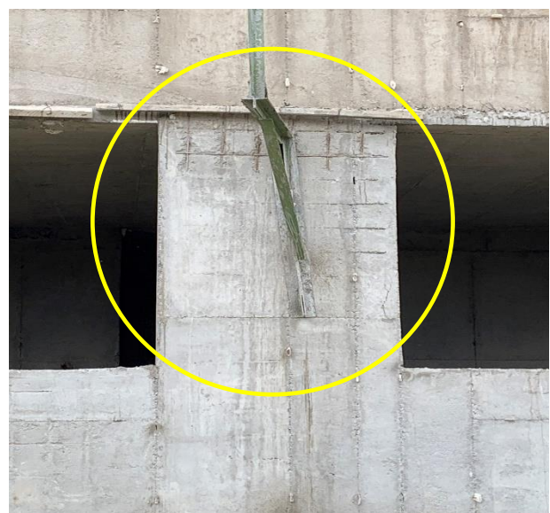
Imagen 4. Tubería de instalaciones eléctricas y malla electrosoldada a la vista, Proyecto denominado "Urbanización Santa Sofia II", (Municipio de El Colegio, 30 de mayo de 2019, 10:00 a.m.)
