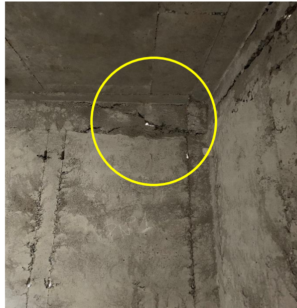
Imagen 3. Evidente hormigueo concreto estructural y fisura muro divisorio, Proyecto denominado "Urbanización Santa Sofia II", (Municipio de El Colegio, 30 de mayo de 2019, 10:00 a.m.)
