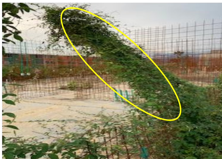
Imagen 5. Malla electrosoldada de refuerzo estructural con perdida de resistencia, Proyecto denominado "Urbanización Santa Sofia II", (Municipio de El Colegio, 30 de mayo de 2019, 11:00 a.m.)
