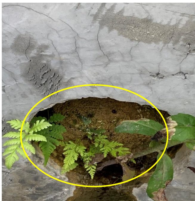
Imagen 8. Cajas de inspección de alcantarillado Sanitario tapada con basura, caja de inspección pluvial tapada con sedimentos de arrastre propios de la tubería y materia vegetal torre 9, Proyecto denominado "Urbanización Santa Sofia II", (Municipio de El Colegio, 30 de mayo de 2019, 4:00 p.m.)
