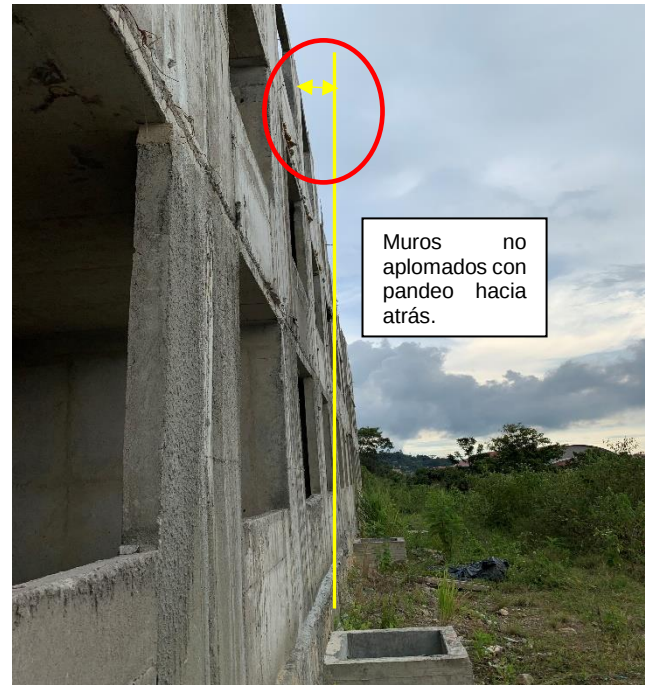
Imagen 7. Concreto con pandeos en muros estructurales torre 9 y 10, dinteles sin terminar y sin espesor mínimos exigido por diseños estructurales y planos, Concreto con socavación debido a la humedad presentada en el piso 2 torre 9, Proyecto denominado "Urbanización Santa Sofía II", (Municipio de El Colegio, 30 de mayo de 2019, 3:00 p.m.)
