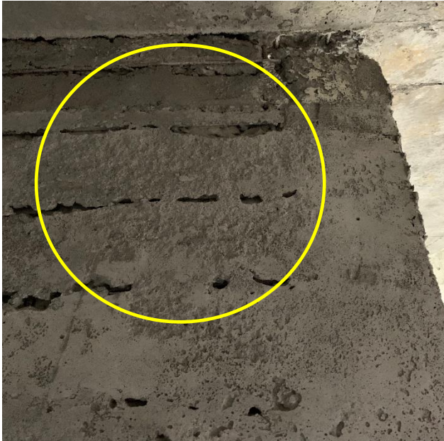
Imagen 3. Evidente hormigueo concreto estructural y fisura muro divisorio, Proyecto denominado "Urbanización Santa Sofia II", (Municipio de El Colegio, 30 de mayo de 2019, 10:00 a.m.)
