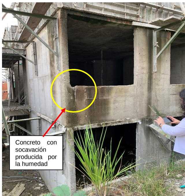
Imagen 7. Concreto con pandeos en muros estructurales torre 9 y 10, dinteles sin terminar y sin espesor mínimos exigido por diseños estructurales y planos, Concreto con socavación debido a la humedad presentada en el piso 2 torre 9, Proyecto denominado "Urbanización Santa Sofía II", (Municipio de El Colegio, 30 de mayo de 2019, 3:00 p.m.)
