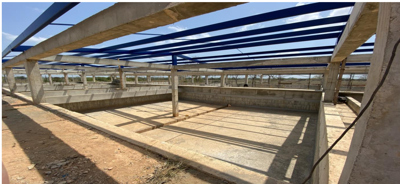
Imagen 7. Lechos de Secado de lodos de la PTAP con capacidad de 350 l/s, el cual no está hidráulico del proyecto perteneciente al proyecto denominado: “Construcción del Sistema de Acueducto Regional San Jorge municipios de La Apartada, Buenavista, Planeta Rica, Pueblo Nuevo”, ubicado en el departamento de Córdoba
