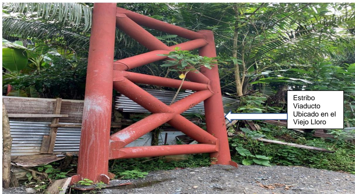
*Imagen 1. Estribos construidos para viaducto de tubería para Agua Potable Proyecto denominado Optimización del Sistema de Abastecimiento de Agua, Municipio de Lloró”, (Municipio de Lloró, 30 de octubre de 2019, 9:00 a.m.)*
