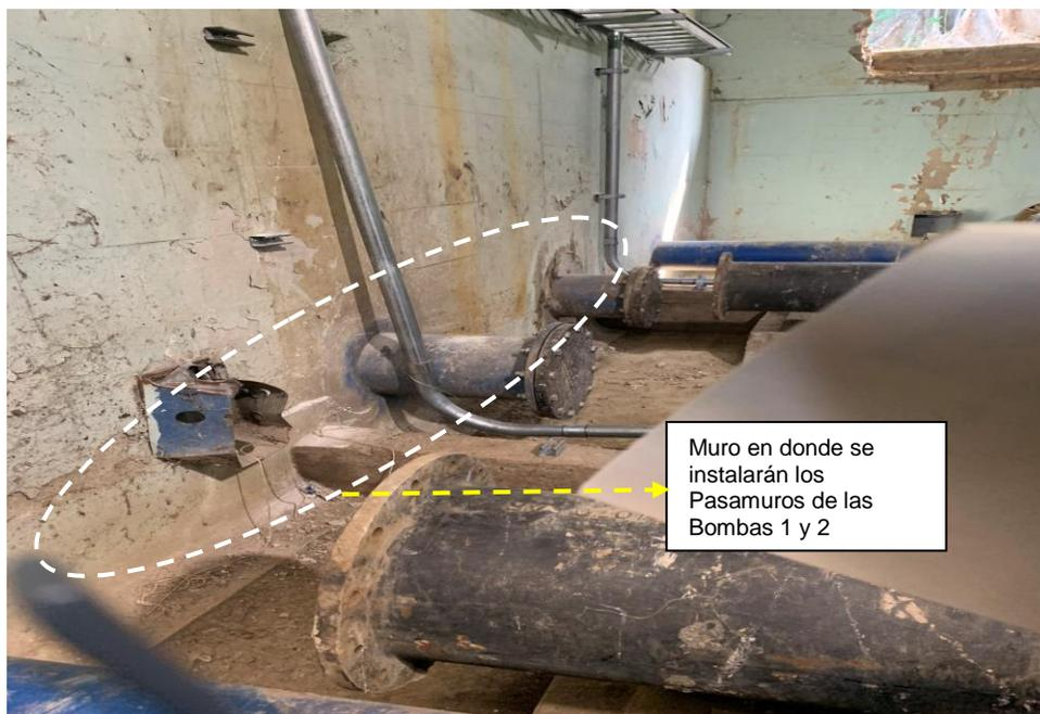
*Imagen 3. Bombas 1 y 2 pendiente instalar Pasamuros para que sean conectadas a la red principal del sistema de acueducto, Proyecto denominado “Optimización, Construcción y Ampliación del Sistema de Distribución del Acueducto del Municipio de Magangué, Departamento de Bolívar”, (Municipio de Magangué, 27 de agosto de 2019, 11:30 a.m.).*
