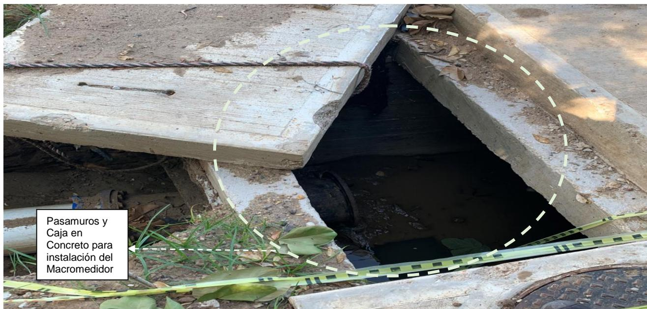
*Imagen 4. Pasamuros y Caja en Concreto para la instalación del Macromedidor sean conectadas a la red principal del sistema de acueducto, Proyecto denominado "Optimización, Construcción y Ampliación del Sistema de Distribución del Acueducto del Municipio de Magangué, Departamento de Bolívar", (Municipio de Magangué, 27 de agosto de 2019, 1:30 p.m.).*
