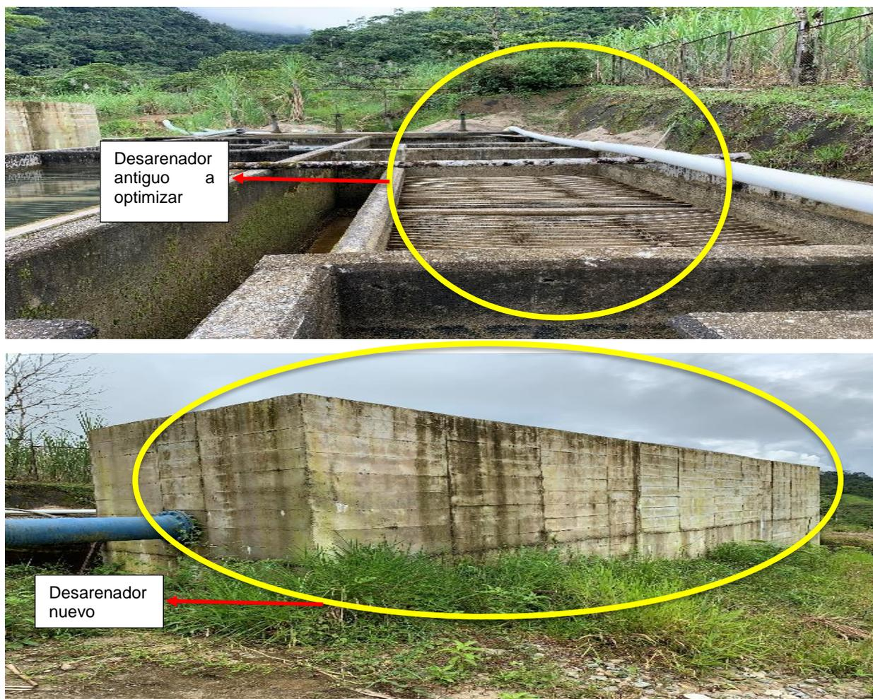
*Imagen 6 Desarenador nuevo terminado y optimización de desarenador antiguo con avance del 20% del Proyecto denominado "RECONSTRUCCIÓN DEL SISTEMA DE ACUEDUCTO DE MOCOCA, PUTUMAYO", (Municipio de Mocoa, 12 de julio de 2019, 9:00 a.m.*
