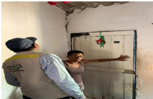
Imagen 3. Fisuras en muros y techos de las viviendas y marco de puerta desajustado, Proyecto denominado "Urbanización Villa Karen", (Municipio de Sincelejo, 22 de agosto de 2019, 2:30 p.m.)
