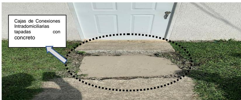
Imagen 2. Salida de aguas residuales y cajas de conexión intradomiciliarias tapadas con concreto, Proyecto denominado "Urbanización Villa Fabiola", (Municipio de Padilla, 24 de octubre de 2019, 10:30 a.m.)
