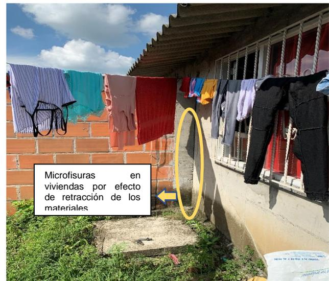
*Imagen1. Microfisuras en Viviendas y muro del patio, viviendas sin presencia de humedades Proyecto denominado "Urbanización Villa Fabiola", (Municipio de Padilla, 24 de octubre de 2019, 9:30 a.m.)*
