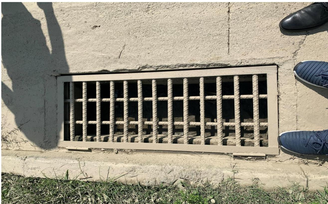
*Imagen 3. Sumideros tapados por falta de mantenimiento por parte de la ESP del Municipio, Proyecto denominado "Urbanización Villa Fabiola", (Municipio de Padilla, 24 de octubre de 2019, 2:30 p.m.)*
