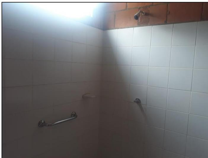
*Imagen 9. Baño para las unidades de vivienda diseñadas para personas con movilidad reducida, se evidencian instaladas las barras de soporte lateral en acero inoxidable, debidamente enchapado, del proyecto denominado: "URBANIZACION VILLA CORAZONISTAS DE PAZ", ubicado en el municipio de El Carmen de Atrato, Departamento de Chocó.*
