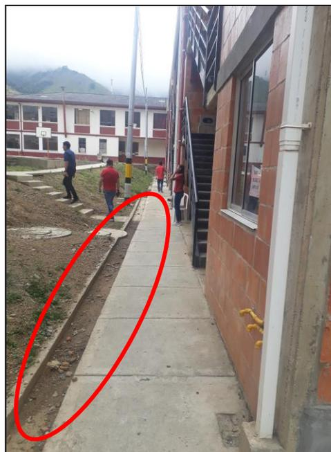
*Imagen 25. Cunetas y sumideros adyacentes a los senderos peatonales, se recomienda realizar limpieza a fin de que no se generen posteriores taponamientos en la tubería de alcantarillado, del proyecto denominado: "URBANIZACION VILLA CORAZONISTAS DE PAZ", ubicado en el municipio de El Carmen de Atrato, Departamento de Chocó.*
