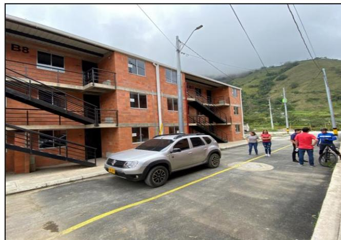
*Imagen 26. Vía interna, se evidencian empozamientos de agua adyacentes a los pozos de inspección del sistema de alcantarillado, lo cual puede generar deterioro en la capa asfáltica, del proyecto denominado: "URBANIZACIÓN VILLA CORAZONISTAS DE PAZ", ubicado en el municipio de El Carmen de Atrato, Departamento de Chocó.*
