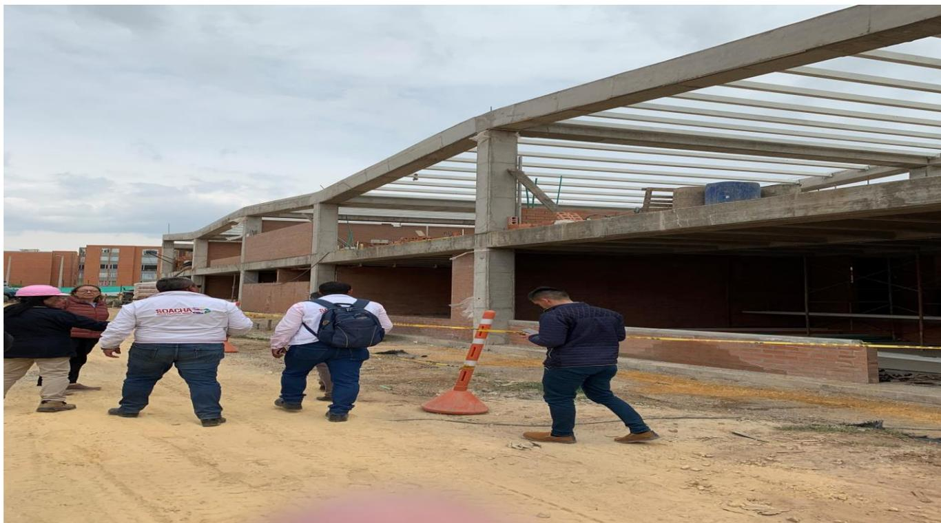
Figura 14. Columnas primer nivel, Placa de entrepiso y Construcción de Muros Laterales Colegio + CDI Vida Nueva – Municipio de Soacha, 14 de marzo de 2019
