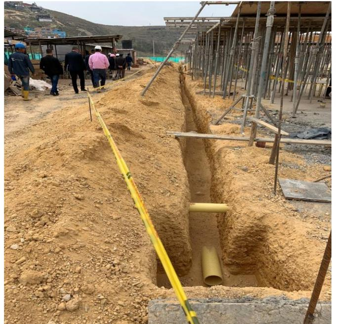
Figura 13. Columnas primer nivel encofradas y tuberías de desagua sanitaria de 6”
