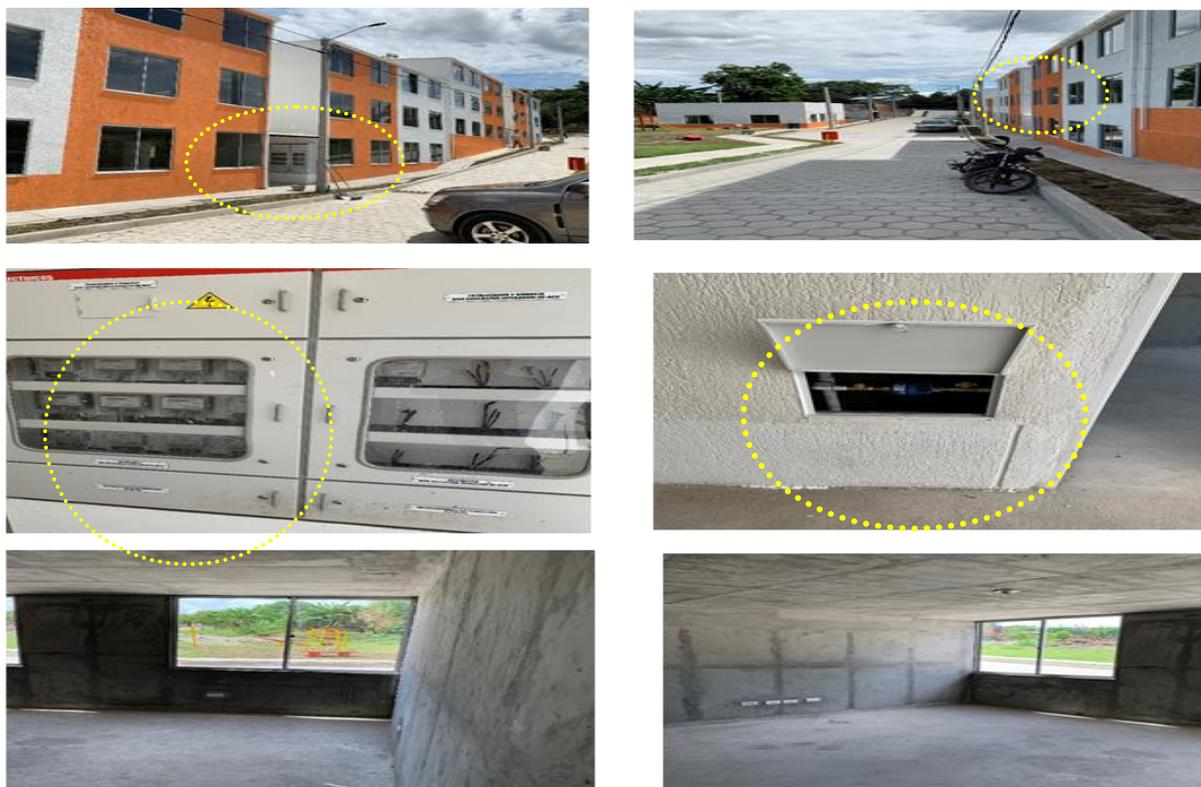
Imagen 4., torres de la urbanización terminadas con sus acabados, cuentan con sus respectivas acometidas domiciliarias tanto del servicio de energía como de acueducto, no se evidencian fisuras, agrietamientos ni humedades Proyecto denominado "Urbanización Dana Valentina" (Municipio de San Luis, 22 de julio de 2019,4:00 p.m.)
