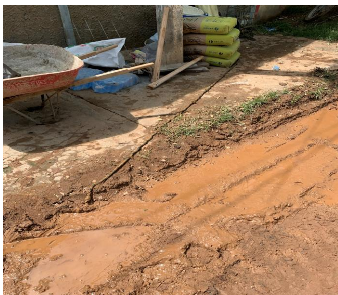
Imagen 5 Zanja para instalación de conexión domiciliaria Calle Cuarta, Proyecto denominado “Construcción, ampliación y optimización del Sistema de Alcantarillado Sanitario de la Cabecera Municipal de Mompox, (Municipio de MOMPOX, 17 de septiembre de 2019, 11:30 a.m.).
