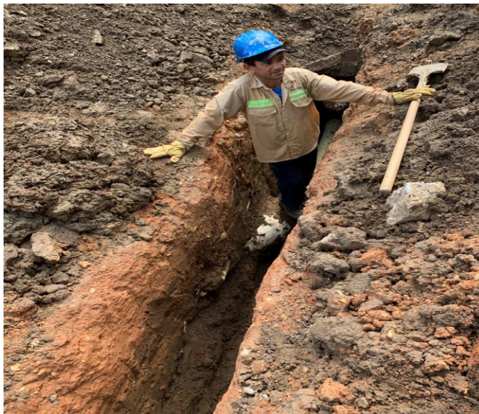
Imagen 5 Zanja para instalación de conexión domiciliaria Calle Cuarta, Proyecto denominado “Construcción, ampliación y optimización del Sistema de Alcantarillado Sanitario de la Cabecera Municipal de Mompox, (Municipio de MOMPOX, 17 de septiembre de 2019, 11:30 a.m.).
