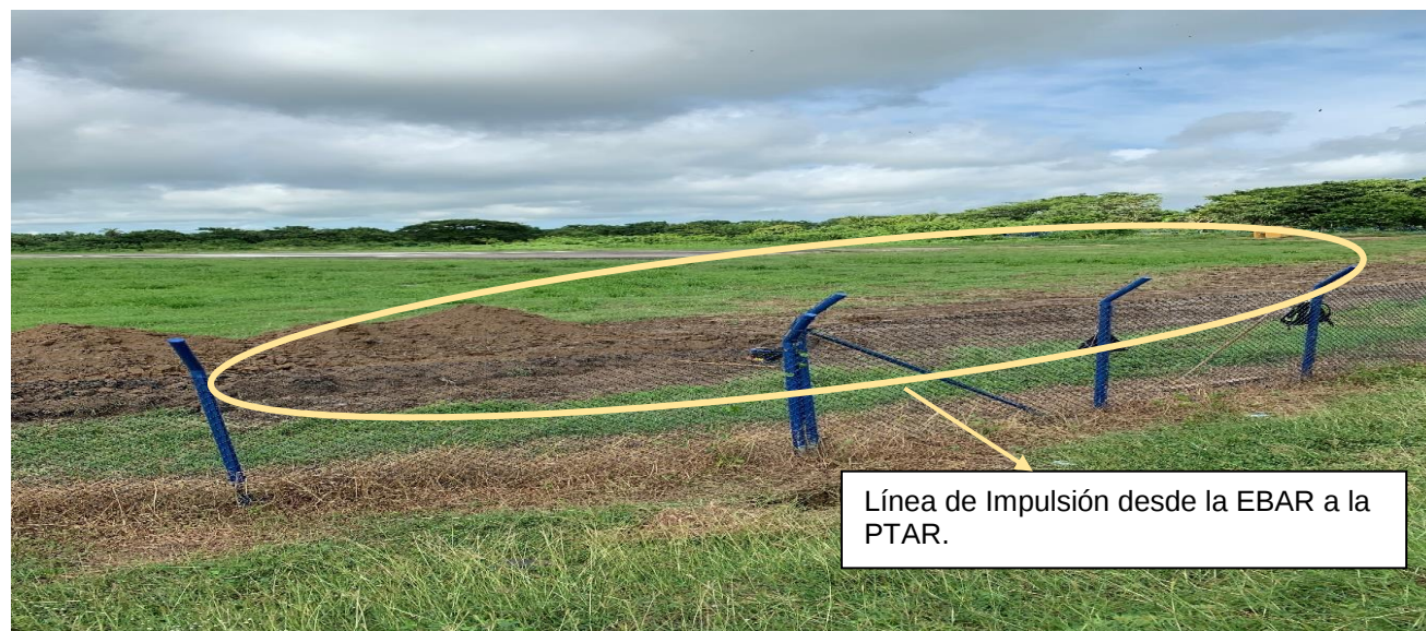
Imagen 3 Línea de Impulsión desde la EBAR a la PTAR, Proyecto denominado “Construcción, ampliación y optimización del Sistema de Alcantarillado Sanitario de la Cabecera Municipal de Mompox, (Municipio de MOMPOX, 17 de septiembre de 2019, 10:00 a.m.).
