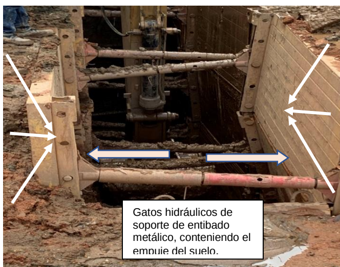
Imagen 4 Entibados y tipo de suelo Calle Cuarta, Proyecto denominado "Construcción, ampliación y optimización del Sistema de Alcantarillado Sanitario de la Cabecera Municipal de Mompox, (Municipio de MOMPOX, 17 de septiembre de 2019, 11:00 a.m.).
