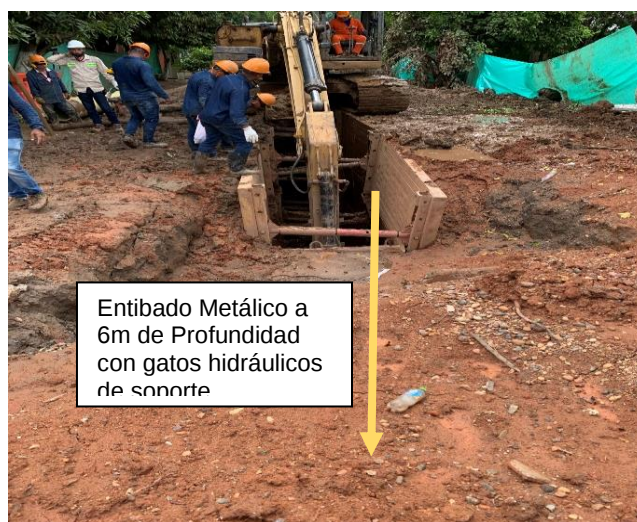
Imagen 4 Entibados y tipo de suelo Calle Cuarta, Proyecto denominado "Construcción, ampliación y optimización del Sistema de Alcantarillado Sanitario de la Cabecera Municipal de Mompox, (Municipio de MOMPOX, 17 de septiembre de 2019, 11:00 a.m.).
