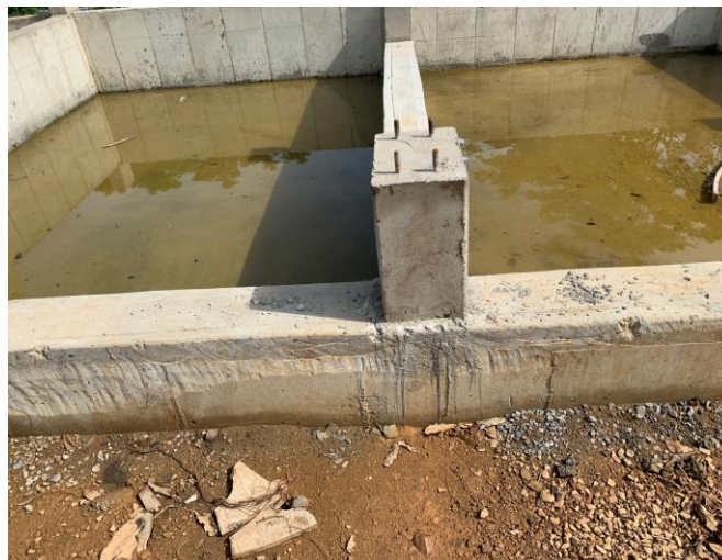
Imagen 2 Estructura de lechos de secado PTAR, Proyecto denominado “Construcción, ampliación y optimización del Sistema de Alcantarillado Sanitario de la Cabecera Municipal de Mompox, (Municipio de MOMPOX, 17 de septiembre de 2019, 9:00 a.m.).
