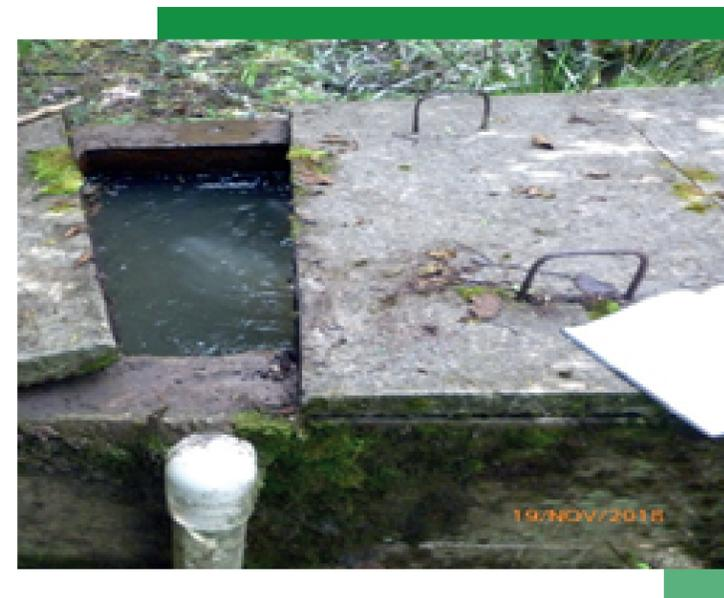
**Fotografía 15.** Desarenador de la Junta administradora Acueducto Daita, sector Carrizal, quebrada Los Chorros.
