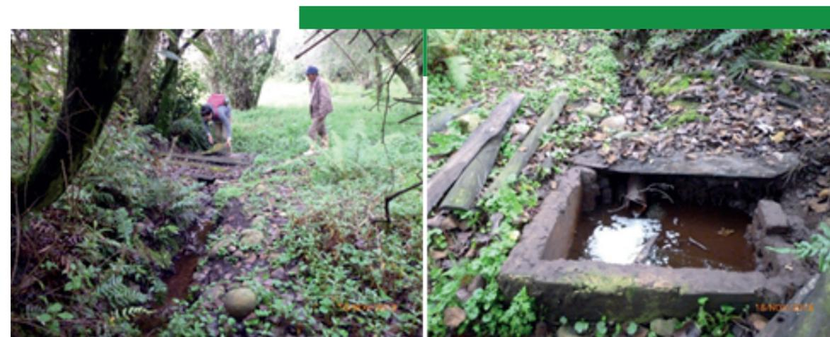
**Fotografías 4 y 5.** Bocatomas de la Asociación de suscriptores del Acueducto de Guantó (Asoguantó): izquierda, en la quebrada Colorados; derecha, en el nacimiento Arenal 2. Ambas captaciones cuentan con buena estructura y funcionamiento.
