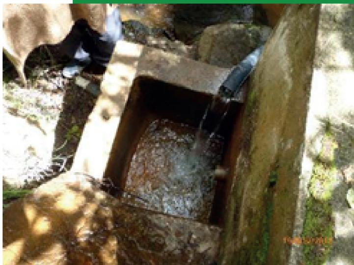
En el caso del acueducto veredal de Potosí, la estructura de captación presenta un estado deficiente. Su construcción permite la entrada de hojas y sedimentos arrastrados por la corriente de agua, pues no posee rejillas ni ningún otro accesorio que impida el ingreso de elementos gruesos contenidos en el agua.
