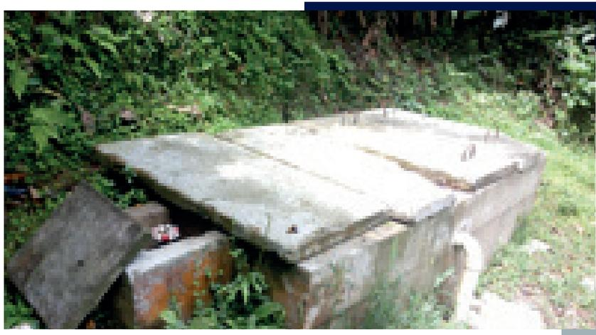
**Fotografía 36.** Desarenador de la vereda Palonegro, en Corinto.
