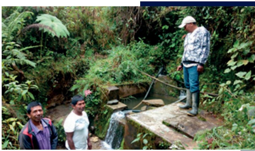
**Fotografía 13.** Captación de la vereda Quebraditas parte baja, en Corinto.
