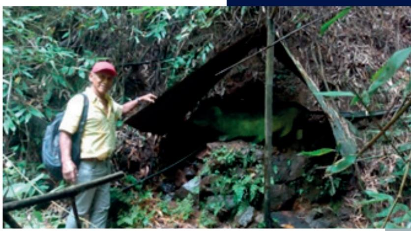
**Fotografía 11.** Captación de trincho de piedra y plástico, compartida entre las veredas Pueblo Nuevo y Pedregal, en Corinto.
