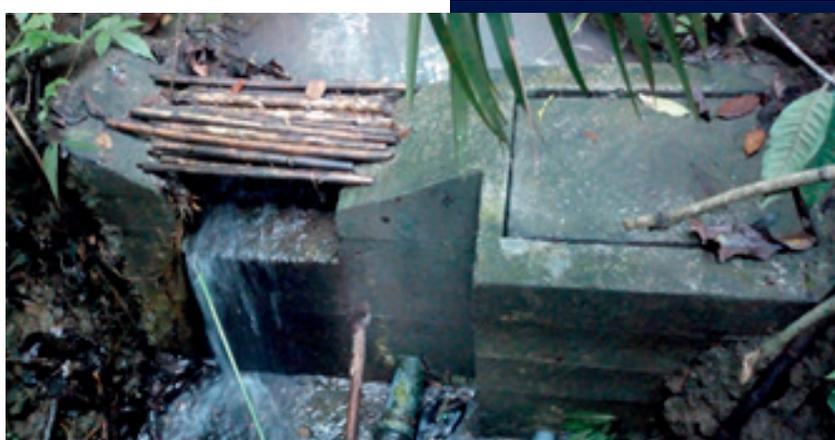
**Fotografía 21.** Captación de la vereda La Capilla parte baja, usada solamente en época de escasez.
