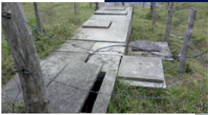
**Fotografía 35.** Desarenadores de la vereda Quebraditas parte baja, en Corinto.
