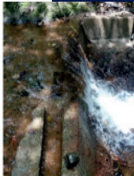
**Fotografía 111.** Captación después de la afectación por la ola invernal, en la quebrada Los Negros, de la vereda San Luis Abajo.
