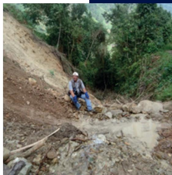
**Fotografía 136.** Tramo más afectado por el deslizamiento (derrumbe). Se sugiere elevar del suelo la tubería de conducción.
