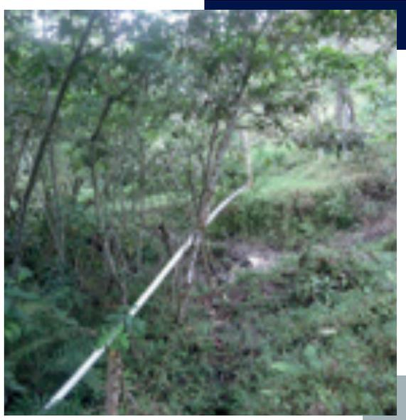
**Fotografía 121.** Tramo cuatro (4) de la tubería de conducción en PVC de dos (2) pulgadas, con una longitud de aproximadamente 150 metros.
