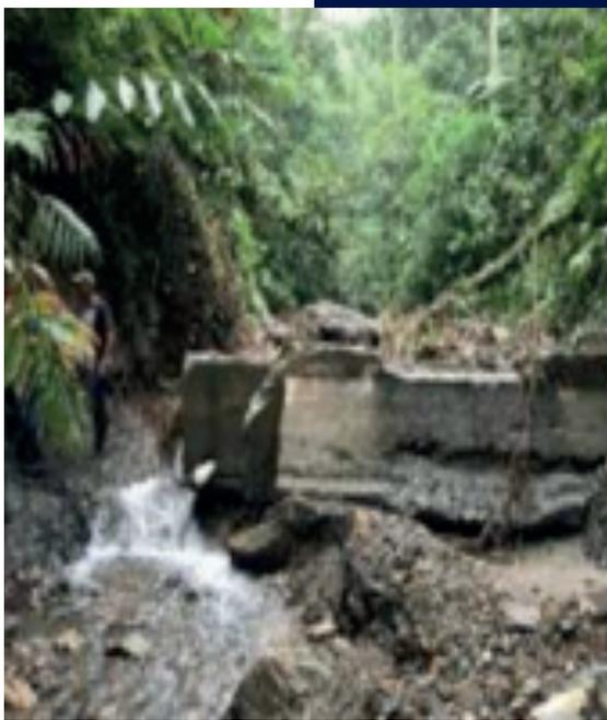
**Fotografía 114.** Bocatoma o captación en la vereda Las Guacas, después de la ola invernal.
