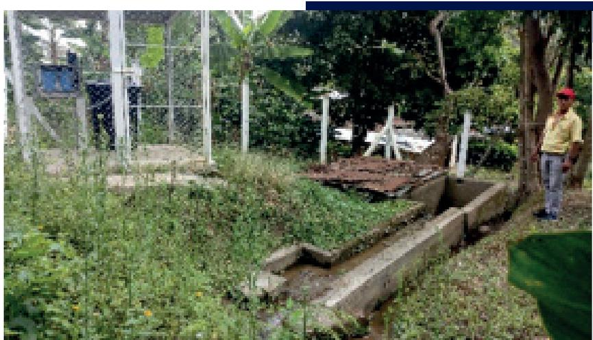
**Fotografía 51.** Sistema de tratamiento 2 tipo FUV2B en la vereda La Heroica, de Corinto.
