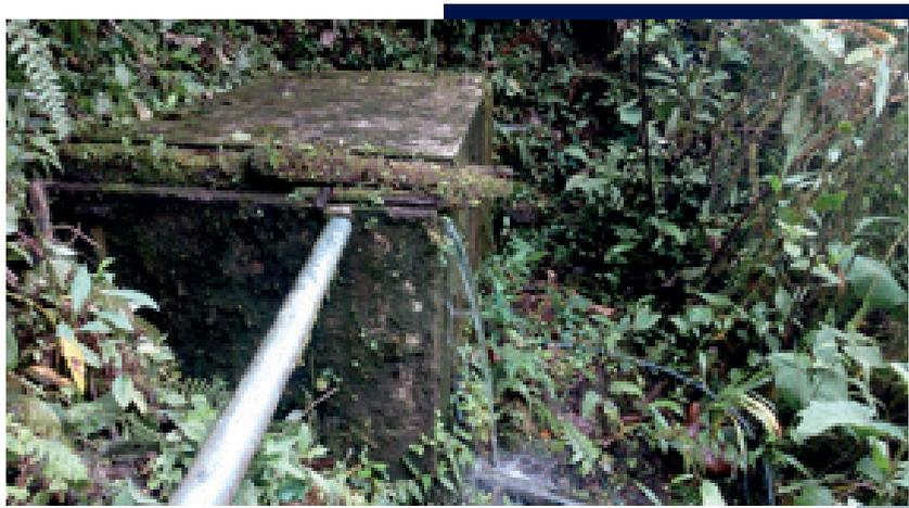
**Fotografía 37.** Desarenador de la vereda La Siberia, en Corinto.
