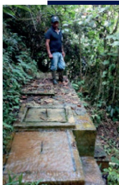
**Fotografías 44 y 45.** Desarenadores de la vereda Las Guacas, en Corinto.
