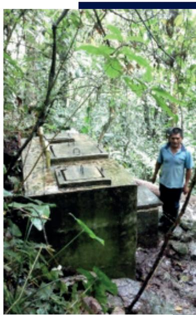
**Fotografía 42.** Desarenador de la vereda Carrizales, en Corinto.
