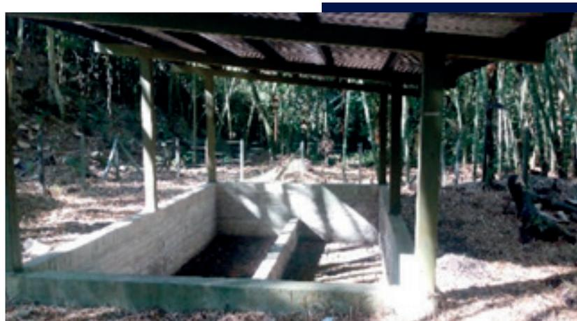
**Fotografía 82.** Tanque séptico y filtro anaerobio en la vereda Pedregal, de Corinto.
