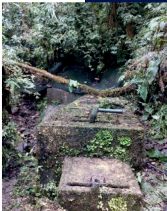
**Fotografía 30.** Desarenador de la vereda El Boquerón, en Corinto.
