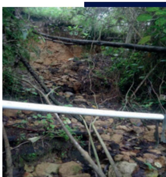
**Fotografía 120.** Tramo tres (3) de la tubería de conducción en PVC de dos (2) pulgadas, con una longitud de entre 20 y 30 metros.
