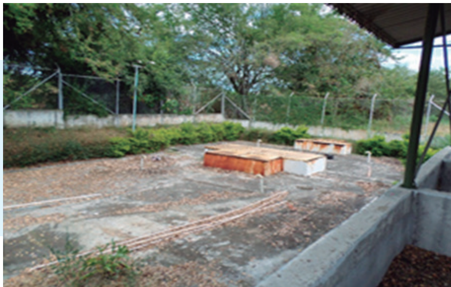
Foto 12. PTAR Chambimbal San Antonio. Guadalajara de Buga - Valle del Cauca
