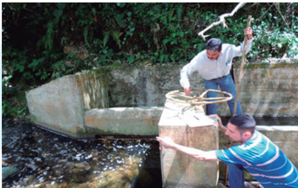
Foto 13. Captación sistema vereda Manantial.
