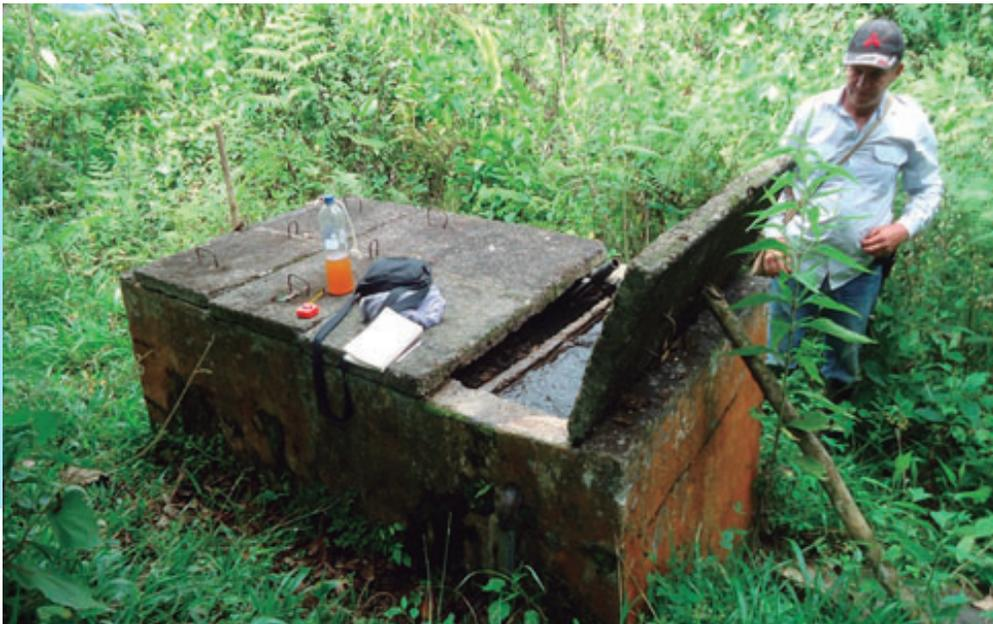
**Foto 11.** Desarenador sistema El Brillante
