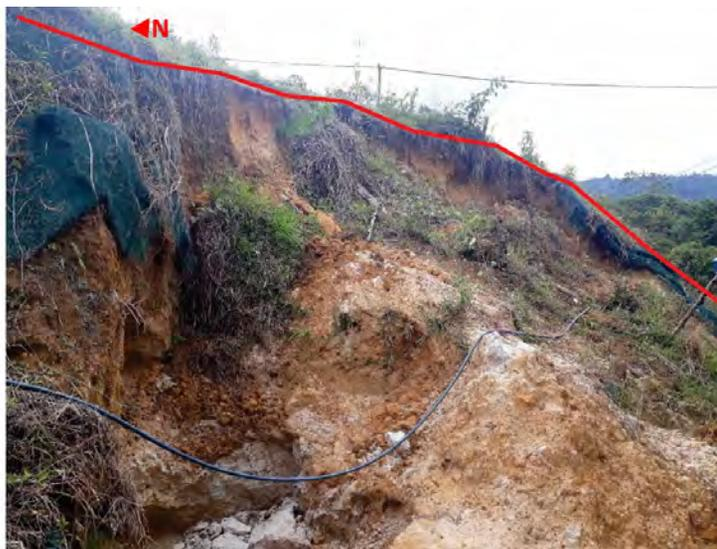
Figura 162: Proceso activo producto de la extracción del suelo como material de construcción
