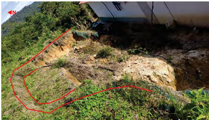
Figura 163: Proceso activo producto de la extracción del suelo como material de construcción
