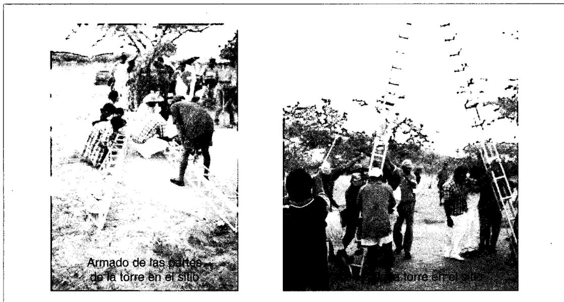
FIGURA 9. Montaje de la torre de perforación
