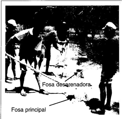
FIGURA 11. Excavación de las fosas de lodo
