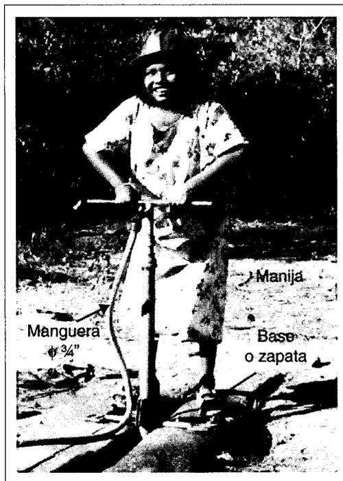
FIGURA 14. Instalación de la bomba de lodo tipo bolivia
