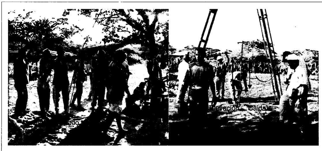
FIGURA 15. Movimiento de percusión: Elevación y caída de las barras de perforación
