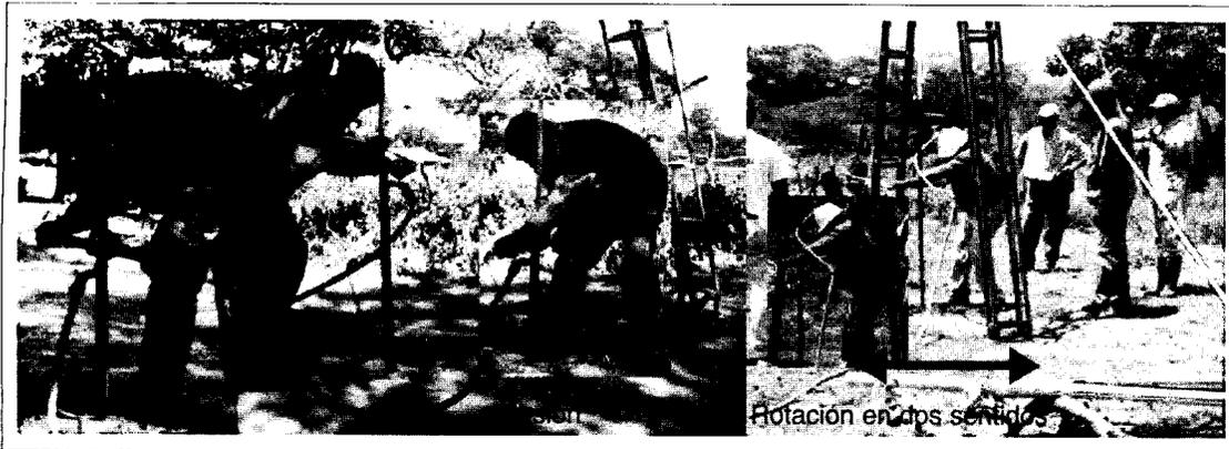
FIGURA 16. Movimiento de rotación: Torsión y rotación en dos sentidos
