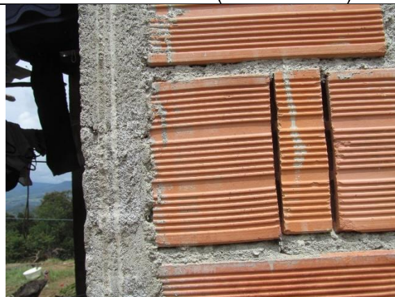
Concreto mal vibrado, superficie porosa (Alfonso Pinzón).
