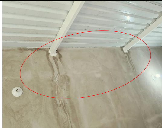
Bloque 1 Torre 3 Apto 502: Humedad en habitación y baño por instalación de cubierta y ventana.
