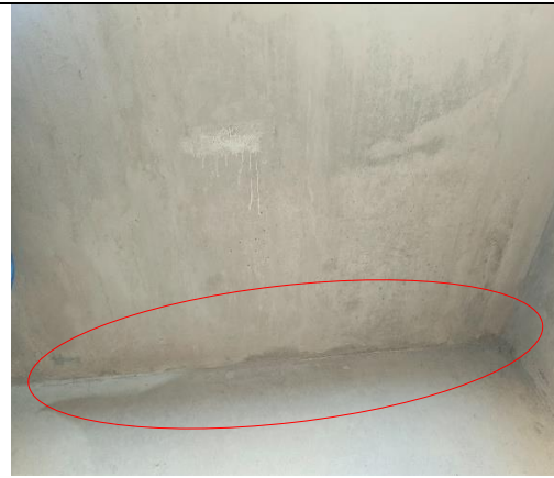
Bloque 2 Torre 2 Apto 101: se presenta filtración de agua por vacío
