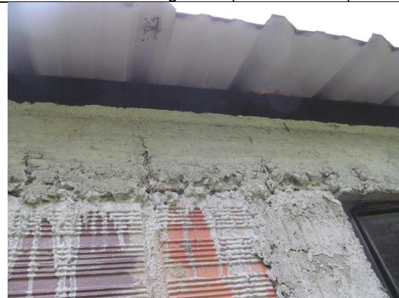
Hormigueros, vacíos en esta columna, la mezcla no es homogénea. (Edilma Umba).
