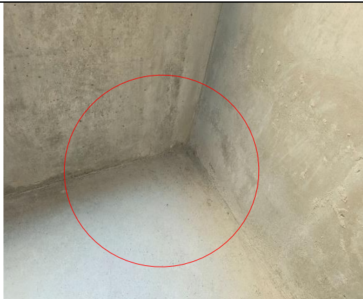
Bloque 2 Torre 2 Apto 101: se presenta filtración de agua por vacío
