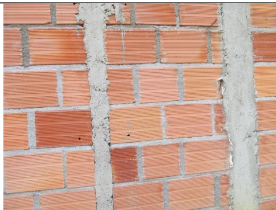
Columnas con anchos diferentes, cambios de dimensiones en una misma columna, la superficie no es uniforme (Alfonso Pinzón).
