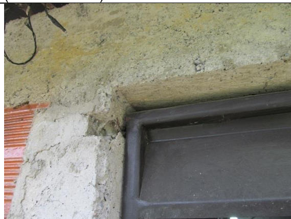
La columna no está fundida en toda su sección (Lina Gisella Suárez)
