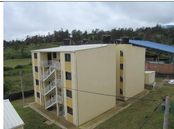
Las zonas verdes, cuarto de basuras, salón social, parqueaderos ya están ejecutados.
