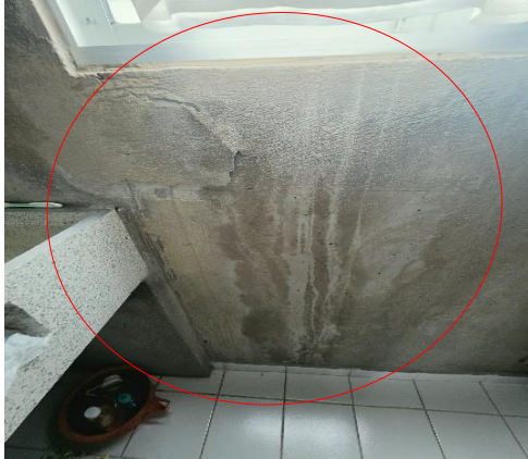
Bloque 2 Torre 2 Apto 502: Humedad en habitación por instalación de cubierta y filtración de agua por ventana de cocina.
