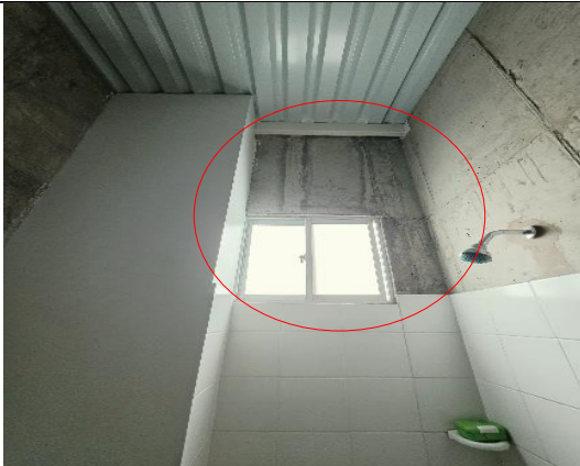
Bloque 1 Torre 3 Apto 502: Humedad en habitación y baño por instalación de cubierta y ventana.
