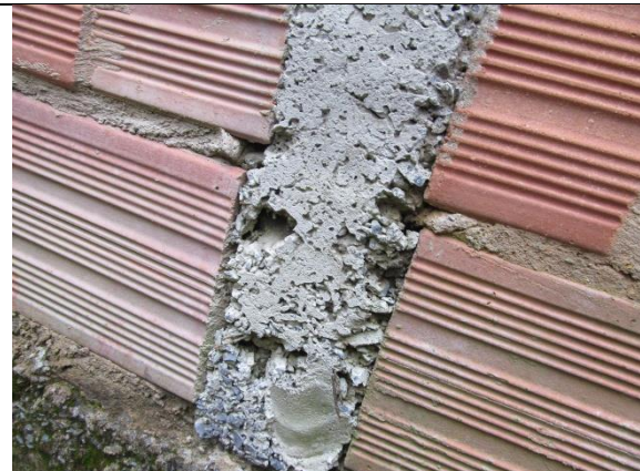
Hormigueros, vacíos en esta columna, la mezcla no es homogénea. (Edilma Umba).
