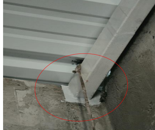
Bloque 2 Torre 2 Apto 502: Humedad en habitación por instalación de cubierta y filtración de agua por ventana de cocina.
