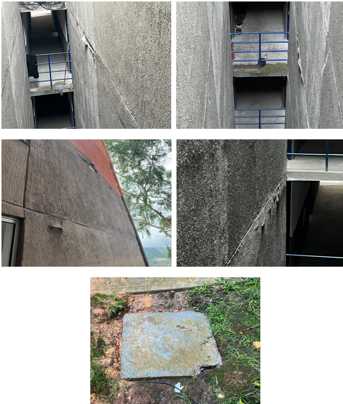
Fuente: Registro fotográfico visita técnica CGR del 14, 15 y 16 marzo de 2023
