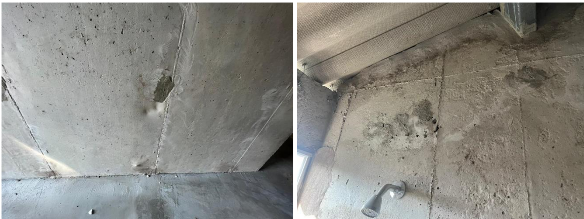
Fuente: Registro fotográfico visita técnica CGR del 30 y 31 marzo de 2023 Fotografía 2: Fisuras en elementos estructurales, malos acabados y mala reparación
