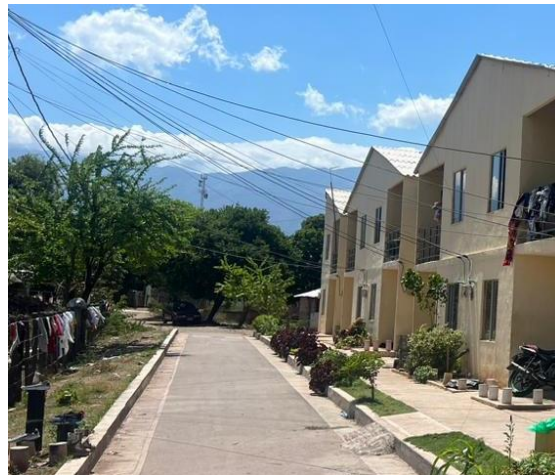
Rampa y Arborizacion
