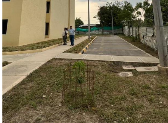
Rampa y Arborizacion
