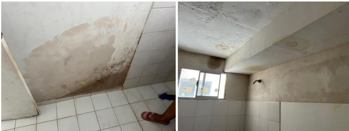
Fuente: Registro fotográfico visita técnica CGR del 21 y 22 marzo de 2023
