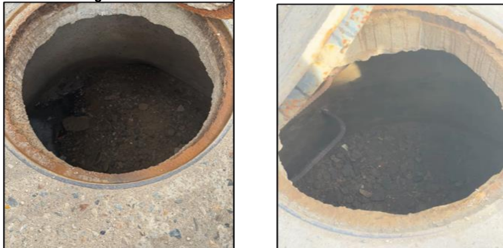
Fotografía 1: Pozos de inspección – Alcantarillado Sanitario
