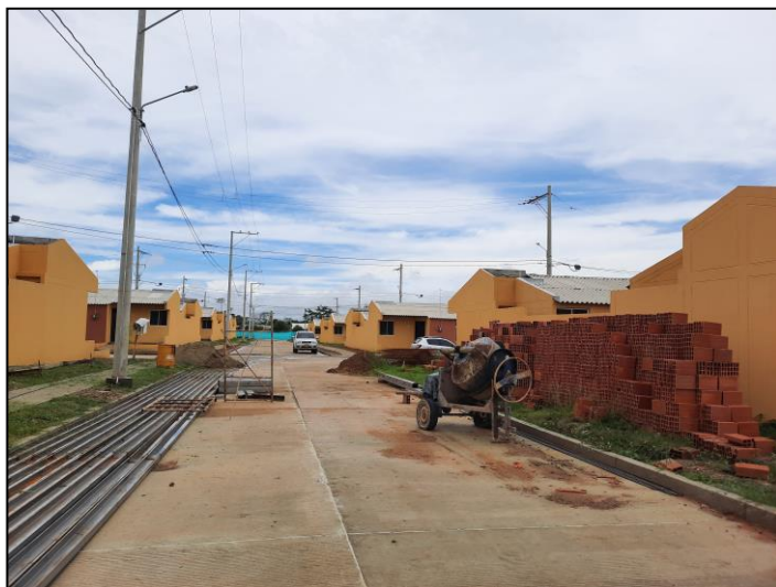
Imagen 2. Vías internas en concreto rígido del proyecto denominado: Efraín Mateus, en el municipio de San Martín, departamento del Cesar.
