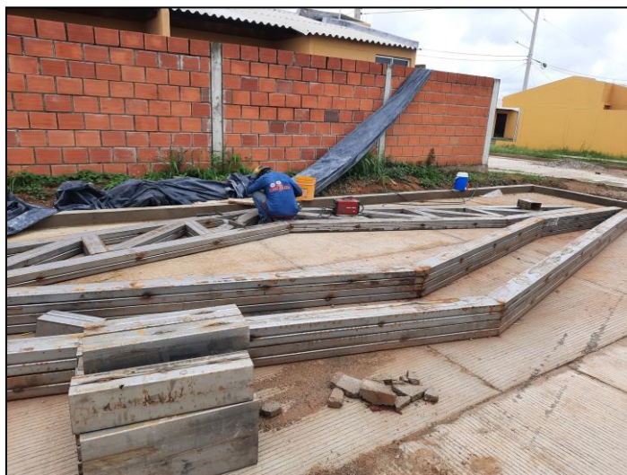
Imagen 19. Armado de cerchas metálicas para cubierta de salón multipropósito del proyecto denominado: Efraín Mateus, en el municipio de San Martín, departamento del Cesar.
