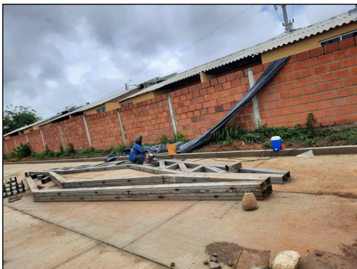
Imagen 19. Armado de cerchas metálicas para cubierta de salón multipropósito del proyecto denominado: Efraín Mateus, en el municipio de San Martín, departamento del Cesar.
