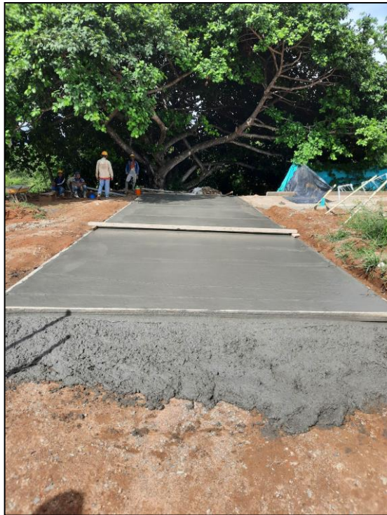
Imagen 21. Fundida de vía externa del proyecto denominado: Efraín Mateus, en el municipio de San Martín, departamento del Cesar.
