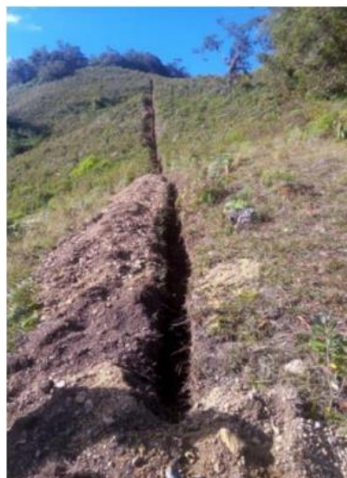
Imagen 7. Excavación para tuberías.
