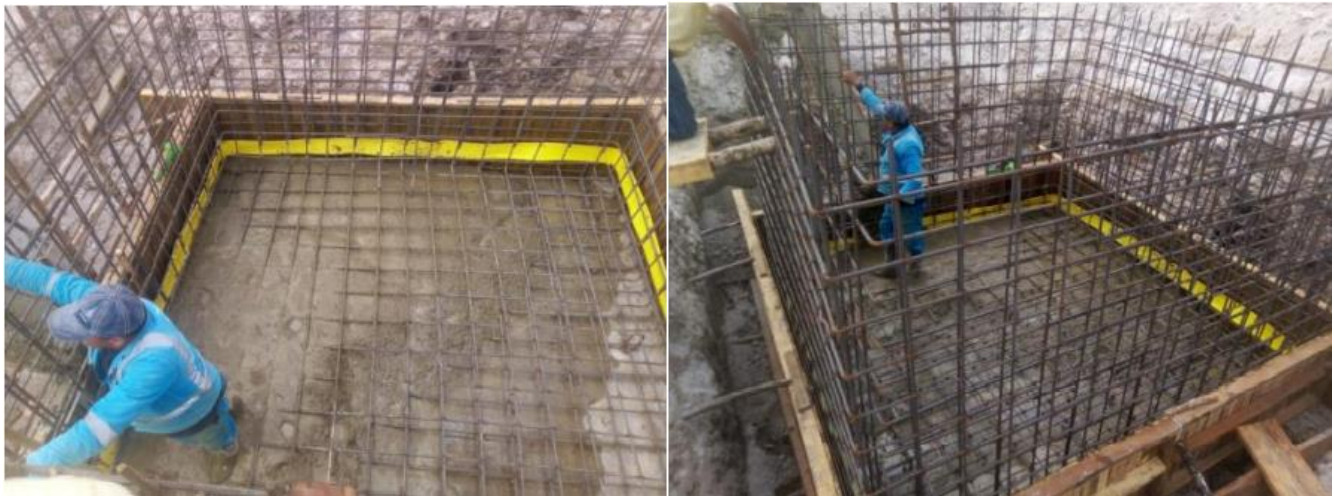
Imágenes 5 y 6. Fundida de placa para piso del tanque de almacenamiento.
