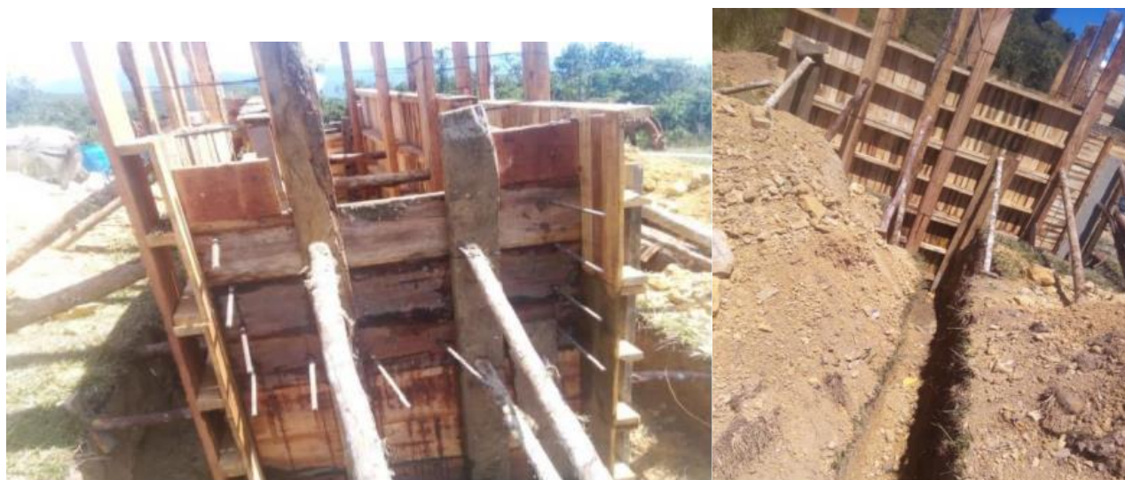
Imágenes 1 y 2. Formaleta para muros del desarenador.
