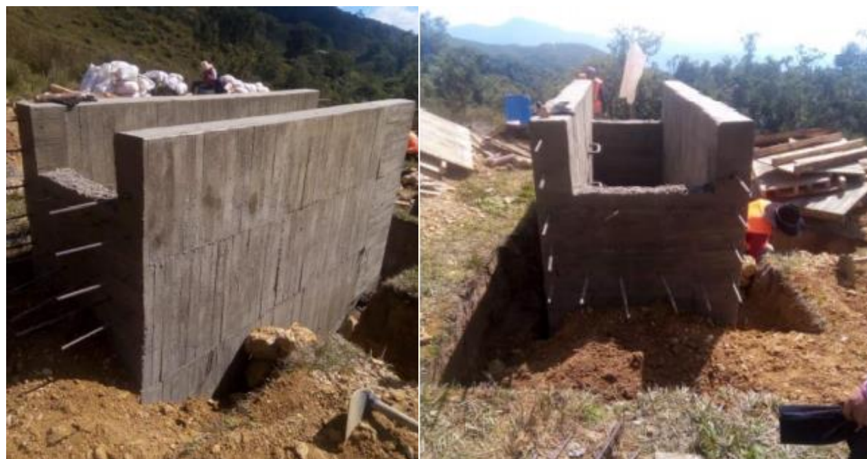
Imágenes 3 y 4. Muros fundidos para el desarenador.
