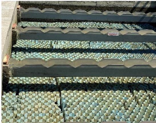
**FOTO No.3:** Sedimentador de alta tasa tipo Colmena con deterioro por falta de un adecuado mantenimiento
