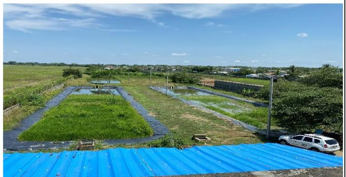
**FOTO No.6:** lechos de secado de lodos sin adecuado mantenimiento
