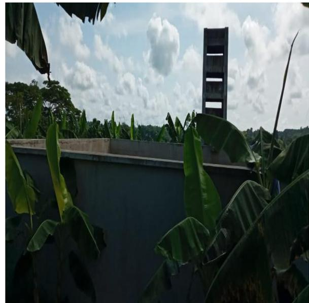
*Imagen 5. Tanques de almacenamiento con su respectivo sistema de bombeo, la cual no está conectado hidráulico del proyecto perteneciente al proyecto denominado: “CONSTRUCCION DEL SISTEMA DE ACUEDUCTO MUNICIPIO DE LOS CORDOBAS, CANALETE Y PUERTO ESCONDIDO”, ubicado en el departamento de Córdoba*
