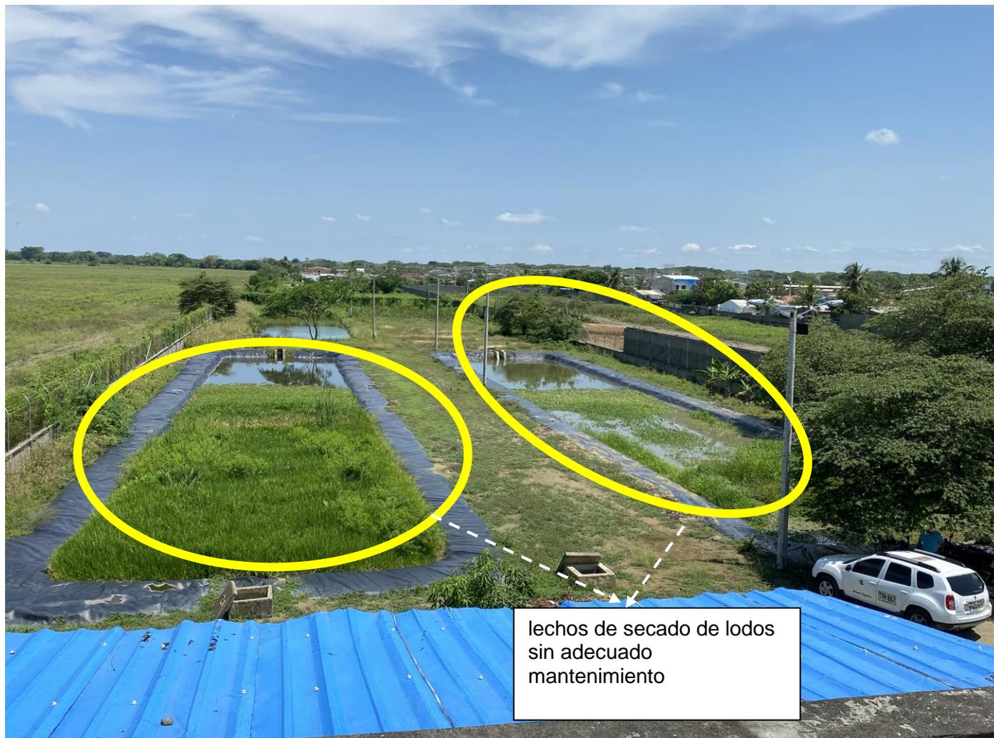
*Imagen 3. Lechos de secado de Lodo pertenecientes al proyecto denominado: “CONSTRUCCION DEL SISTEMA DE ACUEDUCTO MUNICIPIO DE LOS CORDOBAS, CANALETE Y PUERTO ESCONDIDO”, ubicado en el departamento de Córdoba.*
