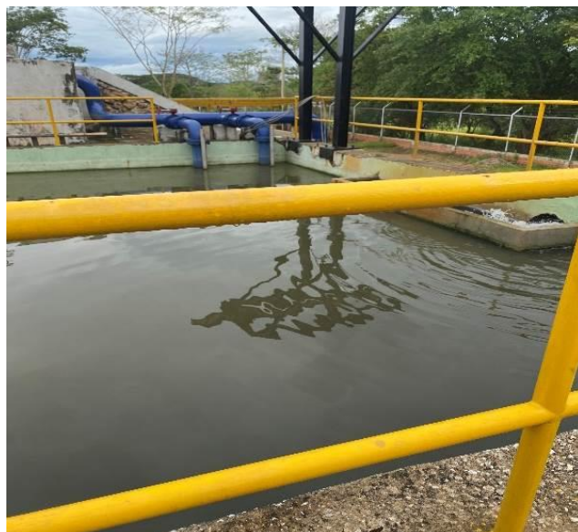
FOTO No.2: Sistema desarenación
