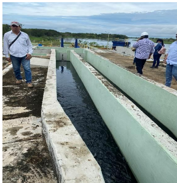
FOTO No.4: Sistema de cribado en una única estructura con dos canales paralelos independientes.
