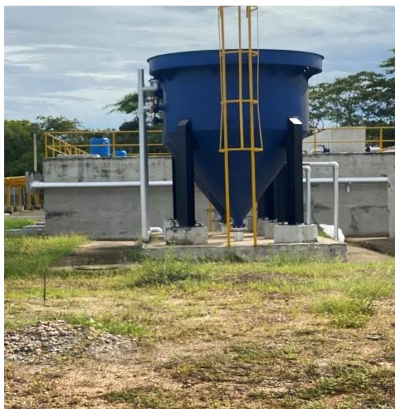
FOTO No.5: Ocho reactores UASB, distribuidos en cuatro trenes independientes, incluye antorcha y biofiltro.
