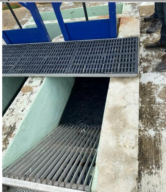
FOTO No.3: Sistema de cribado
