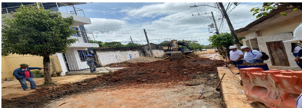
Imagen 3. Calle central del municipio intervenida en su pavimentación y la cual cuenta con tuberías de alcantarillado instaladas al 100%, Municipio de Mompox, Departamento de Bolívar
