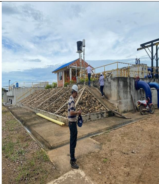
FOTO No.1: Vista lateral PTAR Mpio de Mompox
