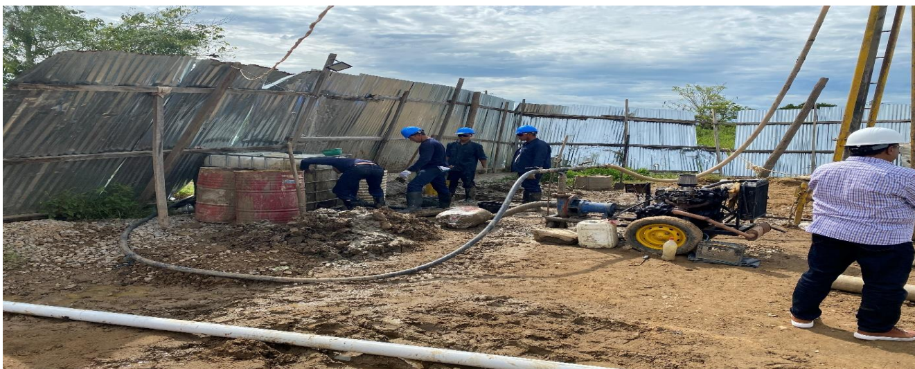
Imagen 2. Estación Elevadora de Aguas Residuales - EEAR Zona Este en construcción, Municipio de Mompox, Departamento de Bolívar
