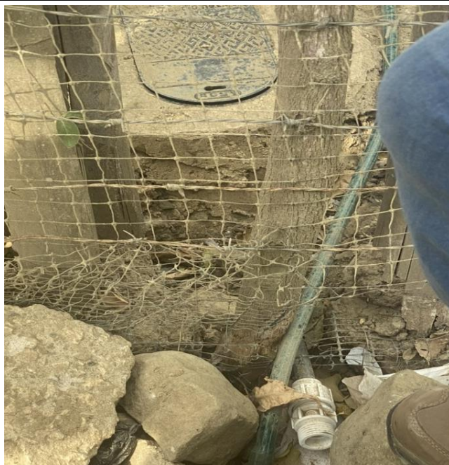
FOTO No.6 Micromedidor instalado, sin embargo se encuentra desconectado de la red principal, Corregimiento la Gallera
