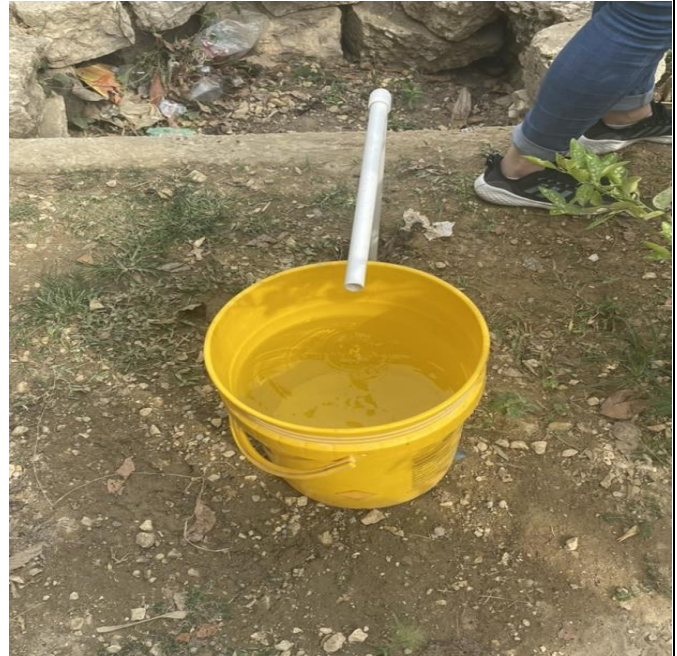
FOTO No.9 Servicio de acueducto del Corregimiento la Gallera en funcionamiento, con una calidad de agua óptima para el consumo humano
