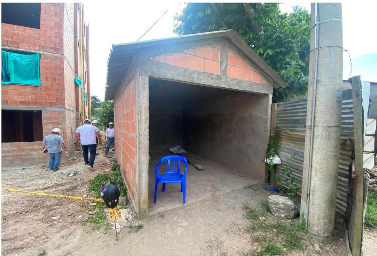
Imagen 3. unidad técnica de recolección de basuras. UTB3 perteneciente al Proyecto de Vivienda "Urbanización San Ignacio" Municipio de San Jose del Guaviare, Departamento del Guaviare
