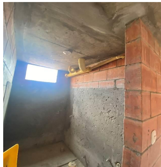
FOTO No.14 Instalación de tubería hidrosanitaria entrepisos baños Torres 1, 2 y 3
