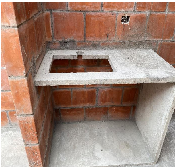
FOTO No.11 Mesón para instalación de lavaplatos torres 1 y 2
