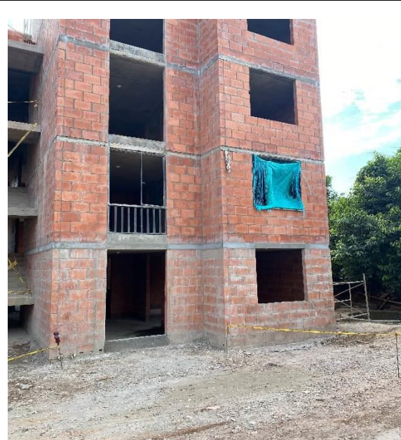
FOTO No.14 Fachada Torre 3 con instalación de ventanería en acero
