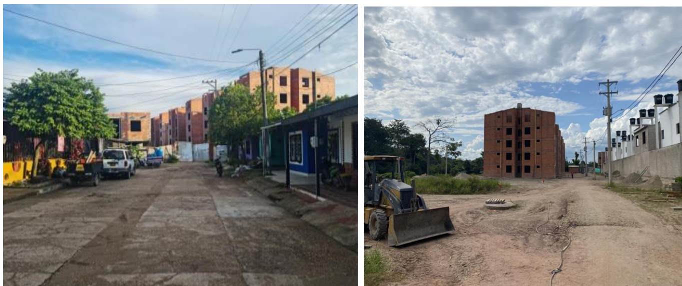
Imagen 6. Estado actual Vías de acceso al Proyecto de Vivienda” Urbanización San Ignacio” Municipio de San Jose del Guaviare, Departamento del Guaviare
