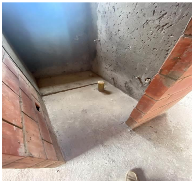
FOTO No.14 Instalación de tubería hidrosanitaria baños Torres 1, 2 y 3
