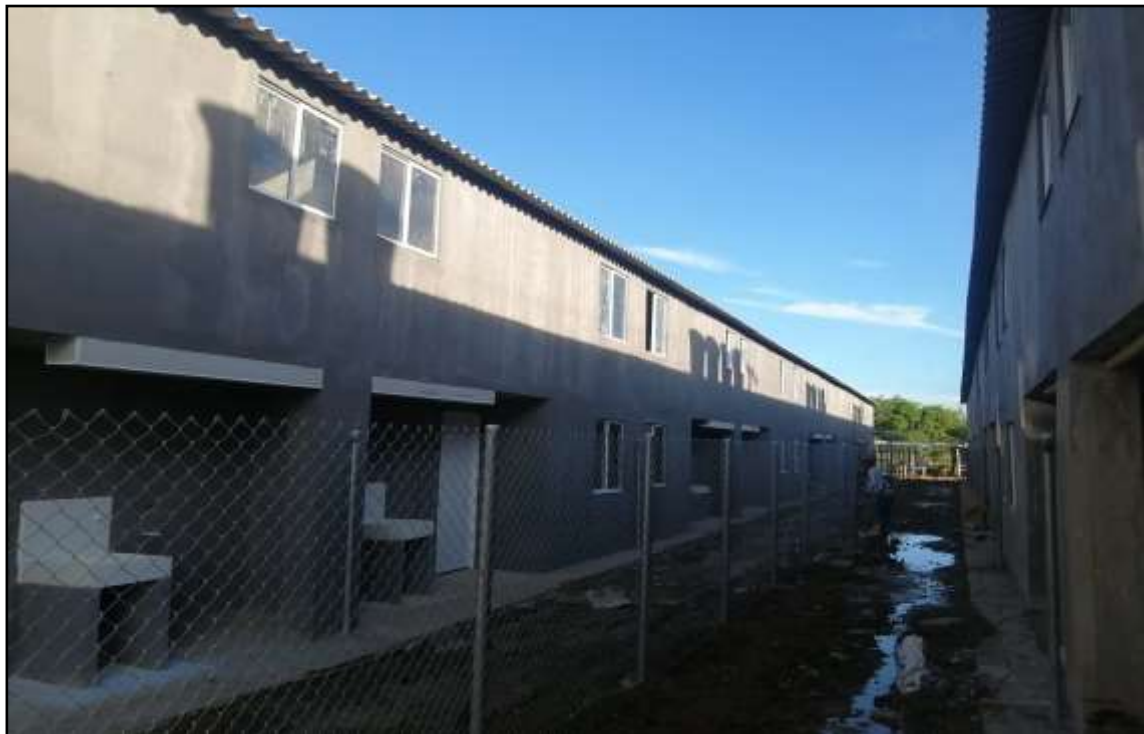
Imagen 8. Fachadas posteriores de las unidades de vivienda del proyecto denominado: Urbanización Joaquín Anaya Etapa II , en el municipio de Chibolo, departamento de Magdalena.
