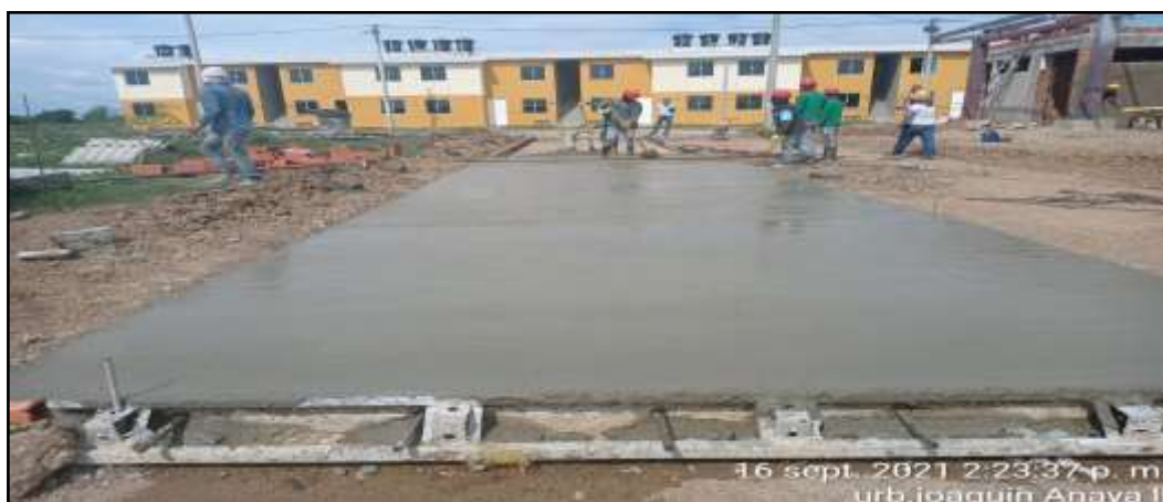
Imagen 2. Fundición de vías internas en pavimento rígido del proyecto denominado: Urbanización Joaquín Anaya Etapa II”, en el municipio de Chibolo, departamento de Magdalena.
