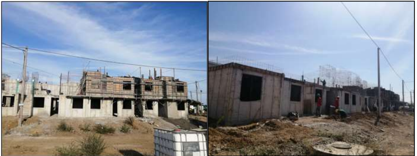
Imagen 7. Armado unidades de vivienda del segundo piso del proyecto denominado: Urbanización Joaquín Anaya Etapa II , en el municipio de Chibolo, departamento de Magdalena.
