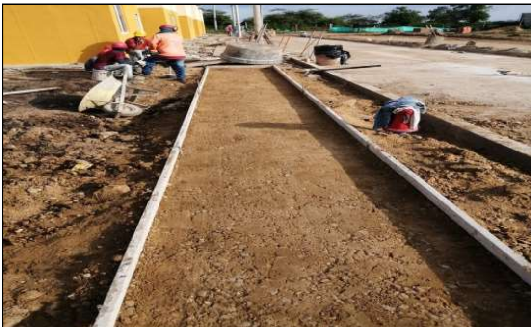
Imagen 14. Compactación de andenes del proyecto denominado: Urbanización Joaquín Anaya Etapa II”, en el municipio de Chibolo, departamento de Magdalena.
