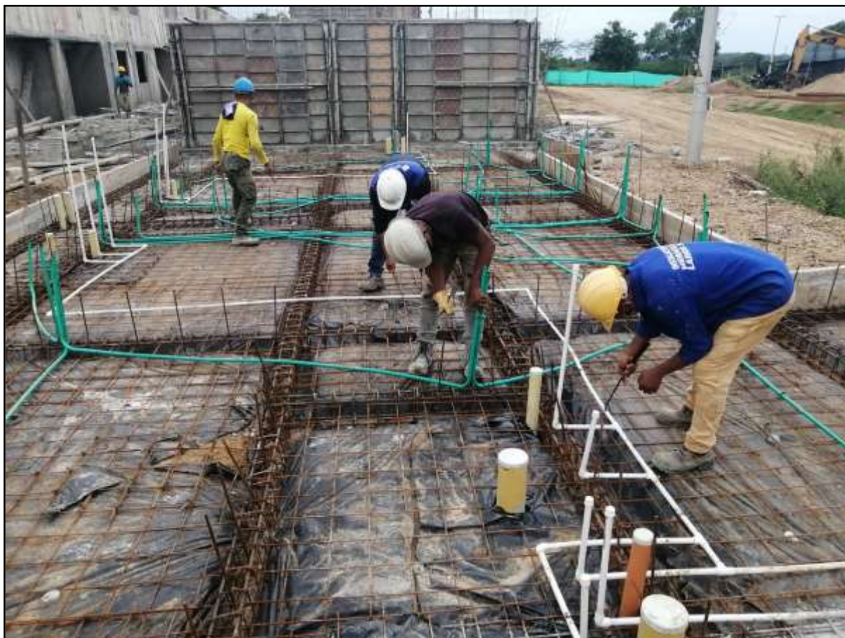
Imagen 5. Amarre de tuberías internas hidráulicas y eléctricas del proyecto denominado: Urbanización Joaquín Anaya Etapa II", en el municipio de Chibolo, departamento de Magdalena.
