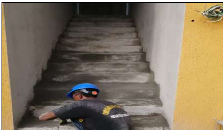
Imagen 12. Escaleras de acceso a las unidades de vivienda de segundo piso del proyecto denominado: Urbanización Joaquín Anaya Etapa II ", en el municipio de Chibolo, departamento de Magdalena.
