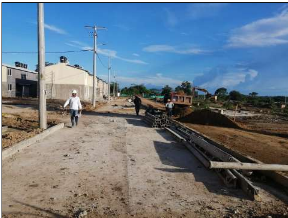
Imagen 11. Vía interna en pavimento rígido del proyecto denominado: Urbanización Joaquín Anaya Etapa II ", en el municipio de Chibolo, departamento de Magdalena.
