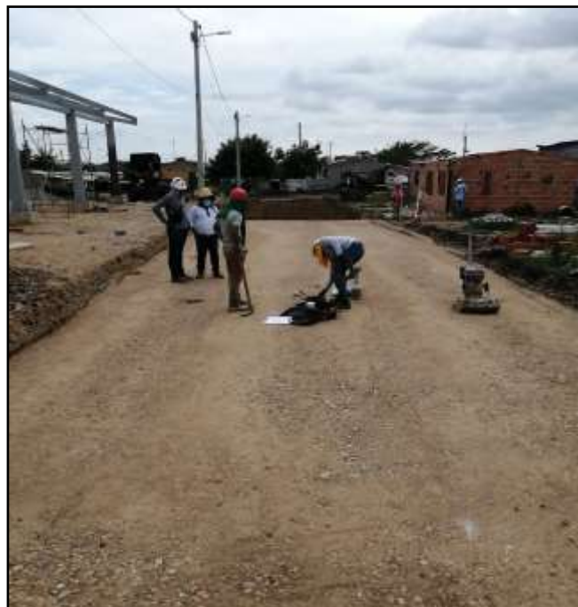
Imagen 10. Toma de muestras para ensayo de laboratorio, de vías internas del proyecto denominado: Urbanización Joaquín Anaya Etapa II ”, en el municipio de Chibolo, departamento de Magdalena.
