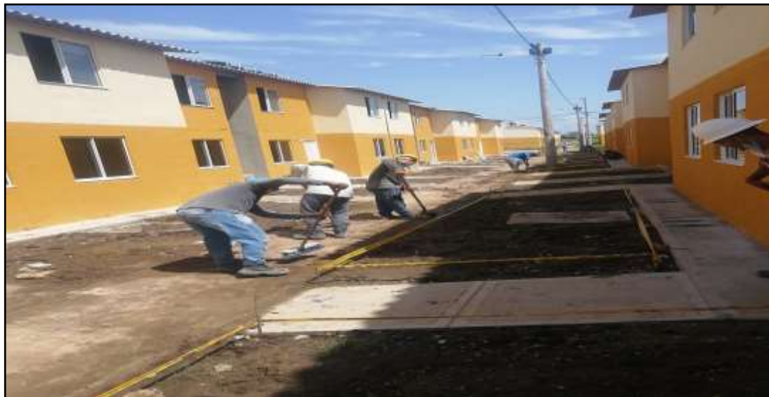
Imagen 13. Limpieza de antejardines para posterior instalación de capa vegetal del proyecto denominado: Urbanización Joaquín Anaya Etapa II”, en el municipio de Chibolo, departamento de Magdalena.
