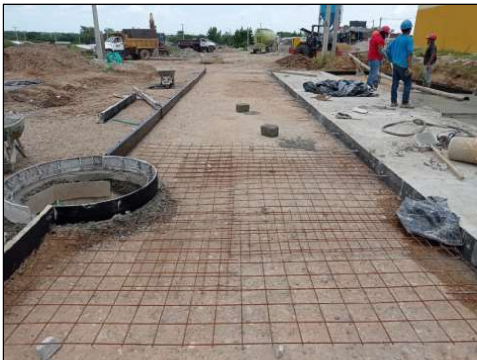
Imagen 3. Armado de vías internas en pavimento rígido del proyecto denominado: Urbanización Joaquín Anaya Etapa II ", en el municipio de Chibolo, departamento de Magdalena.
