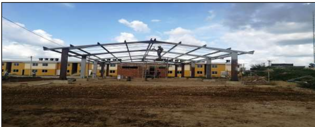
Imagen 6. Pintura de cercha de cubierta del salón comunal del proyecto denominado: Urbanización Joaquín Anaya Etapa II", en el municipio de Chibolo, departamento de Magdalena.
