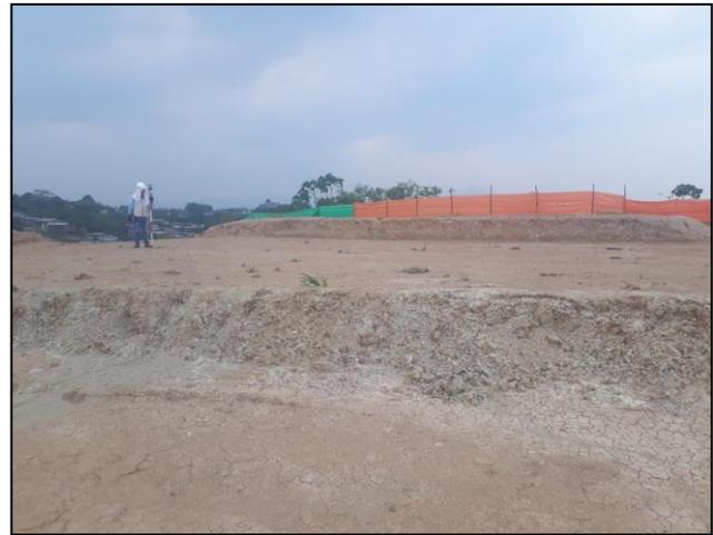
*Imagen 3. Comisión de topografía realizando replanteo y toma de niveles en el predio destinado para la construcción del proyecto "URBANIZACIÓN VILLA JOEL".*
