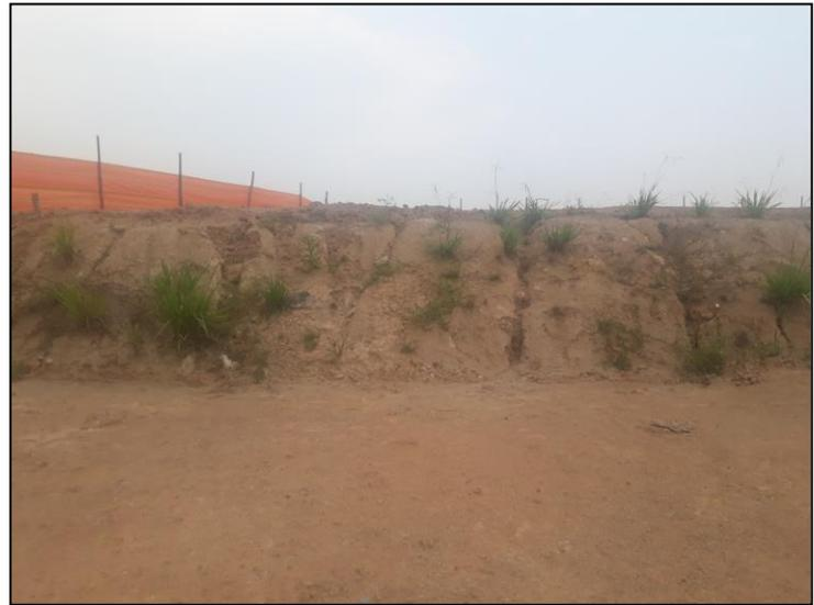
*Imagen 5. Terraza destinada para la construcción del tanque de almacenamiento, de no modificarse la ubicación del mismo, debe rediseñarse la cimentación, con el fin de evitar fallas en la estructura.*
