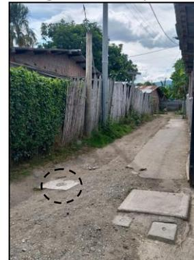
Imagen 14. Caja de válvula de purga con tapa en uno de los callejones Nieva, incluidos al diseño en la reformulación, corregimiento Matapalo.
