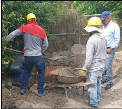
Imagen 15. Construcción en serie de cajas para instalación de válvulas de purga, corregimiento Matapalo.
