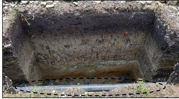
Imagen 6. Tubería de polietileno de alta densidad de 6 pulgadas, soporta de manera segura presión nominal de 10 bares (145 PSI), en la caja de inspección donde se instalará macromedidor. Camino Herradura – Palmira, corregimiento La Herradura.
