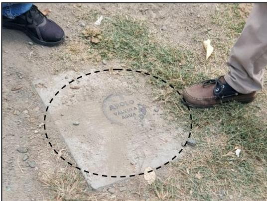
Imagen 2. Caja de válvula de purga con tapa. Corregimiento de Obando.
