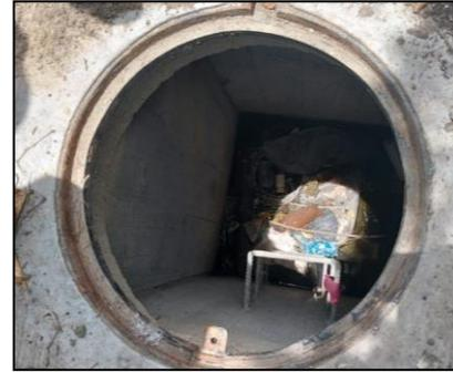
Imagen 8. Caja de válvula de purga con tapa hurtada, camino La Herradura – Palmira, corregimiento La Herradura.
