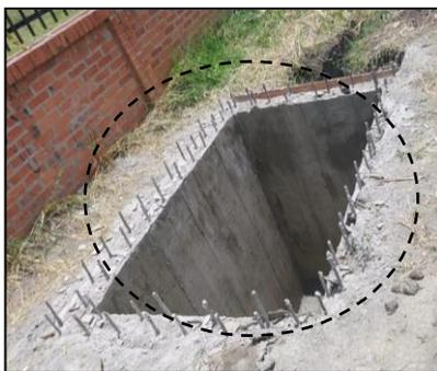
Imagen 9. Caja de macromedidor con hierros a nivel, terminada y dispuesta para instalación de accesorios y loza superior. Frente a la Universidad Antonio Nariño.
