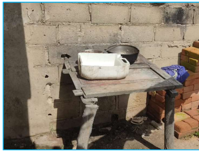
Ausencia de lavadero
