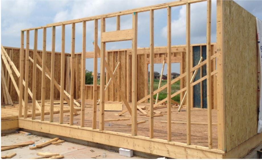
Figura 16. Ejemplo de entramado liviano de madera <https://www.acmetools.com/blog/build-a-wall-with-a-door-simple-1-2-3/>
